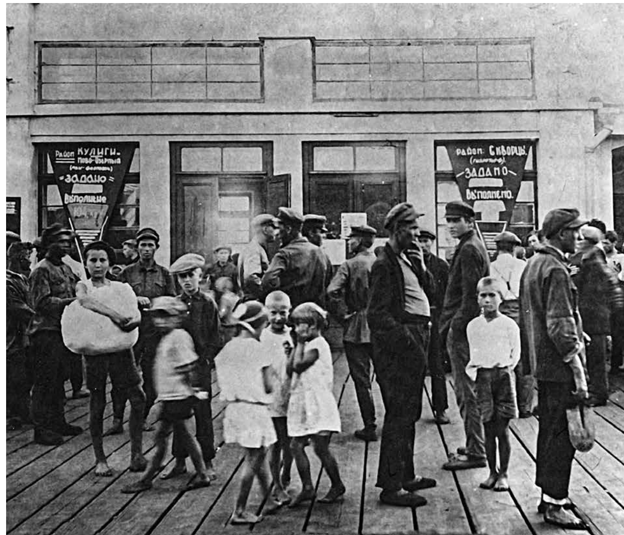
У ж.-д. станции пос. Электропередача. 1930-е гг..
