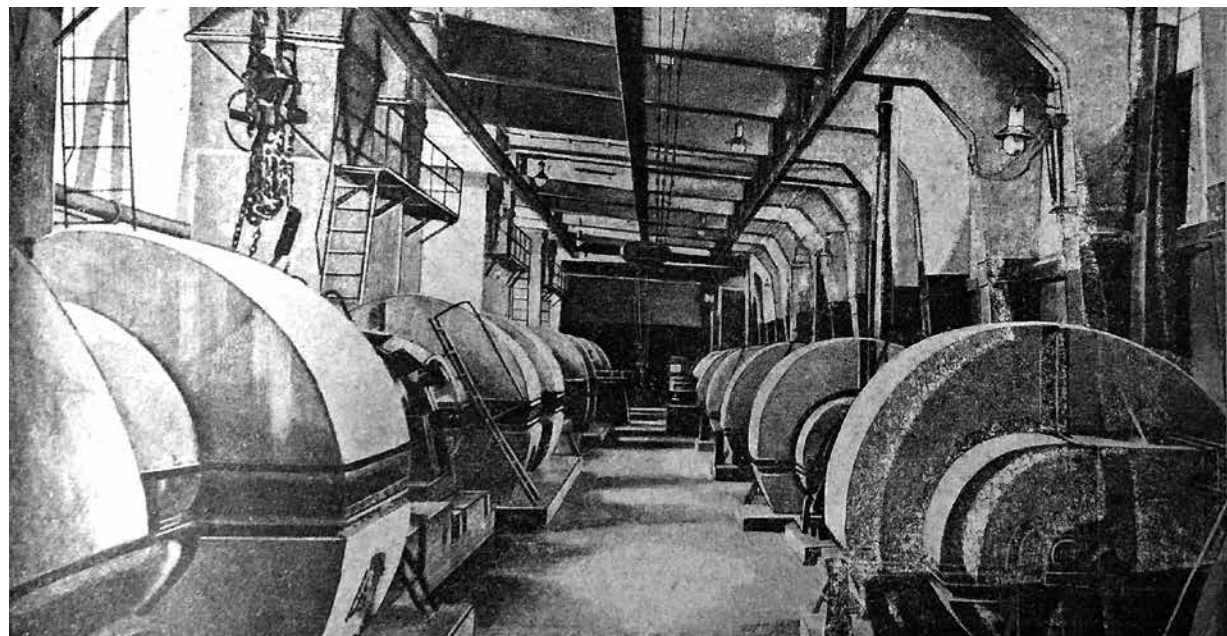
Дымососная галерея Сталиногорской ГРЭС.
