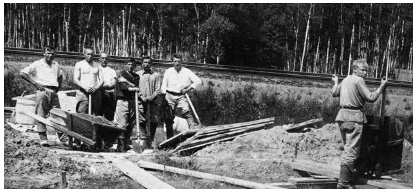
Работы по прокладке высоковольтных линий электропередачи. Фото В.В. Гульденбалька. 1930-е гг.
