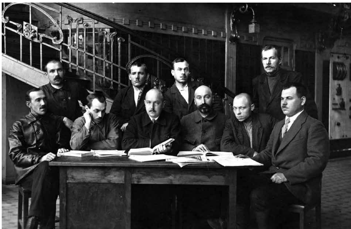
Работники Глуховской электростанции у щита управления. Сидит (третий слева) – зав. станцией В.М. Гурычев. 1923 г.
