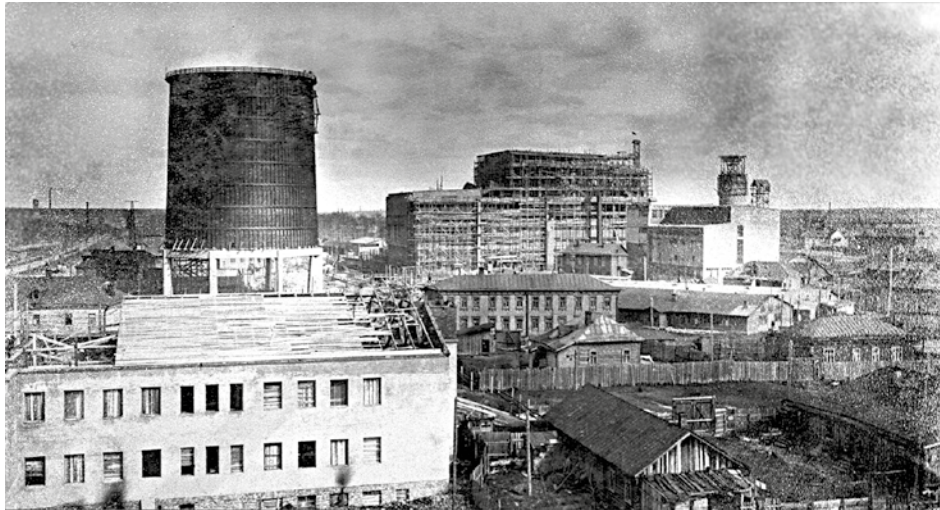
Общий вид строительства ТЭЦ-11 со стороны клуба «Пролетарий».
