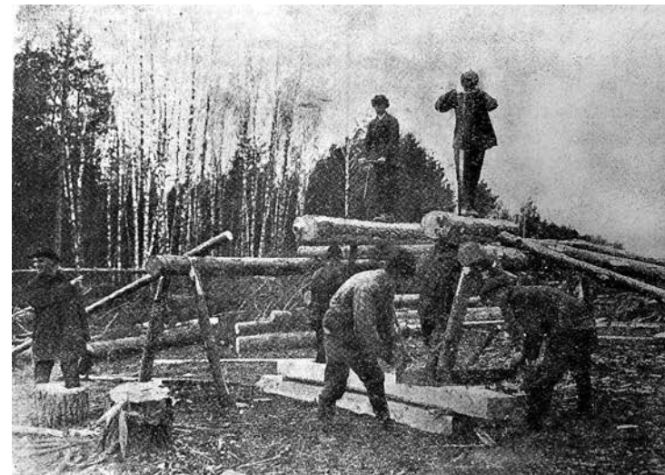
Заготовка шпал (2-я дистанция).
