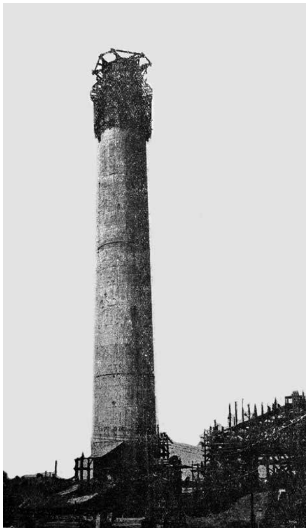
Дымовая труба 1-й очереди СТЭЦ. Труба, выполненная из железобетона, высотой 120 м, является первой по высоте в Советском Союзе. На Западе имеется всего 6 труб с такой высотой.
