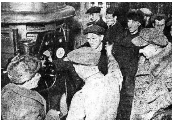
У работающего насоса. Момент включения механизмов водяных задвижек береговой насосной станции.
