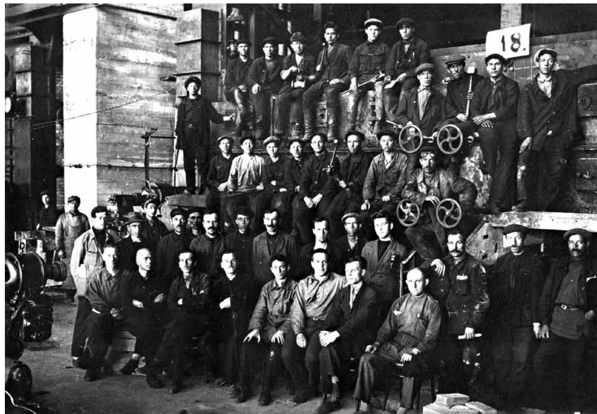
На монтаже котлоагрегата № 18 в котельной № 3 Шатурской ГРЭС. Фото 1930-х гг.
