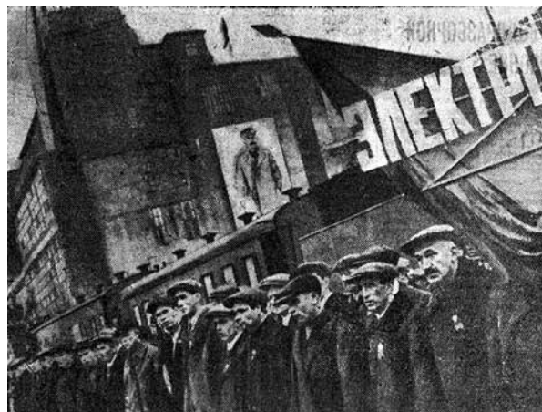
17 и 18 ноября на Каширской электростанции состоялся 2-й областной слет лучших ударников электростанций Московской области. На фото: делегаты конференции перед митингом у Каширской ГЭС. Фото С. Вейнберга и В. Шустина.
