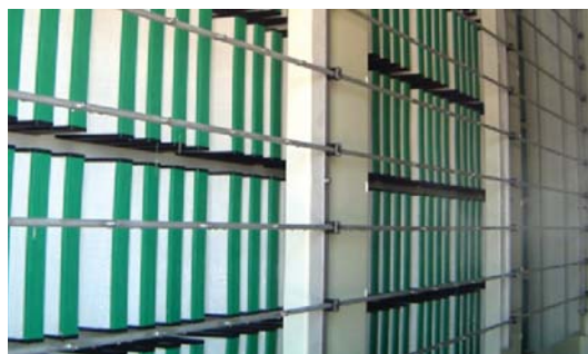
Рис. 2.87. Система подачи ХОВ за фильтрами КВОУ ГТУ [21]
