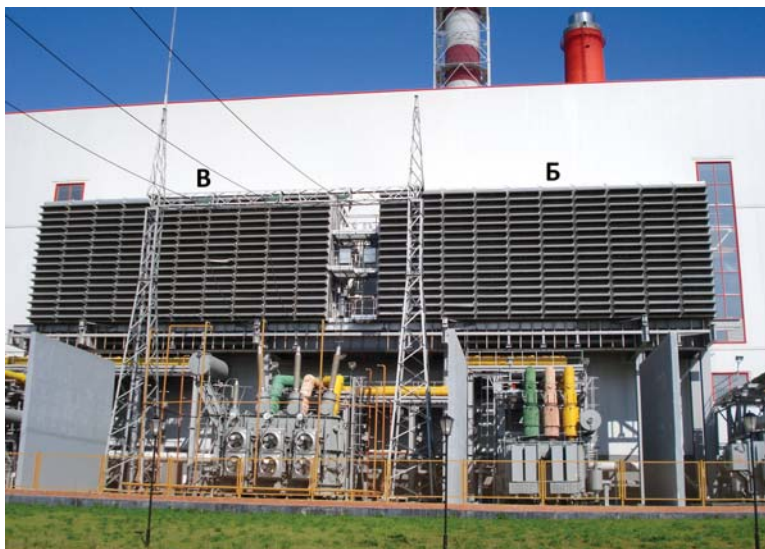
Рис. 5.9. Внешний вид КВОУ ГТУ Б и В ТЭЦ в САО
