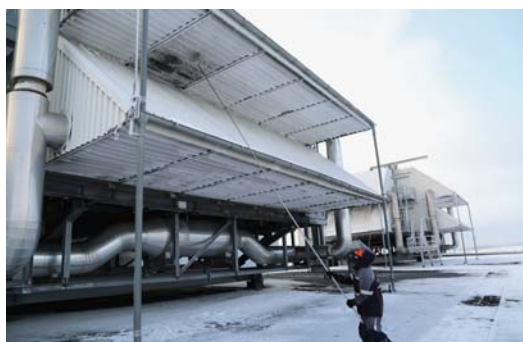
Рис. 2.52. Очистка защитных сеток от птиц на КВОУ ГТЭ-160 ООО «Хуадянь-Тенинская ТЭЦ»
