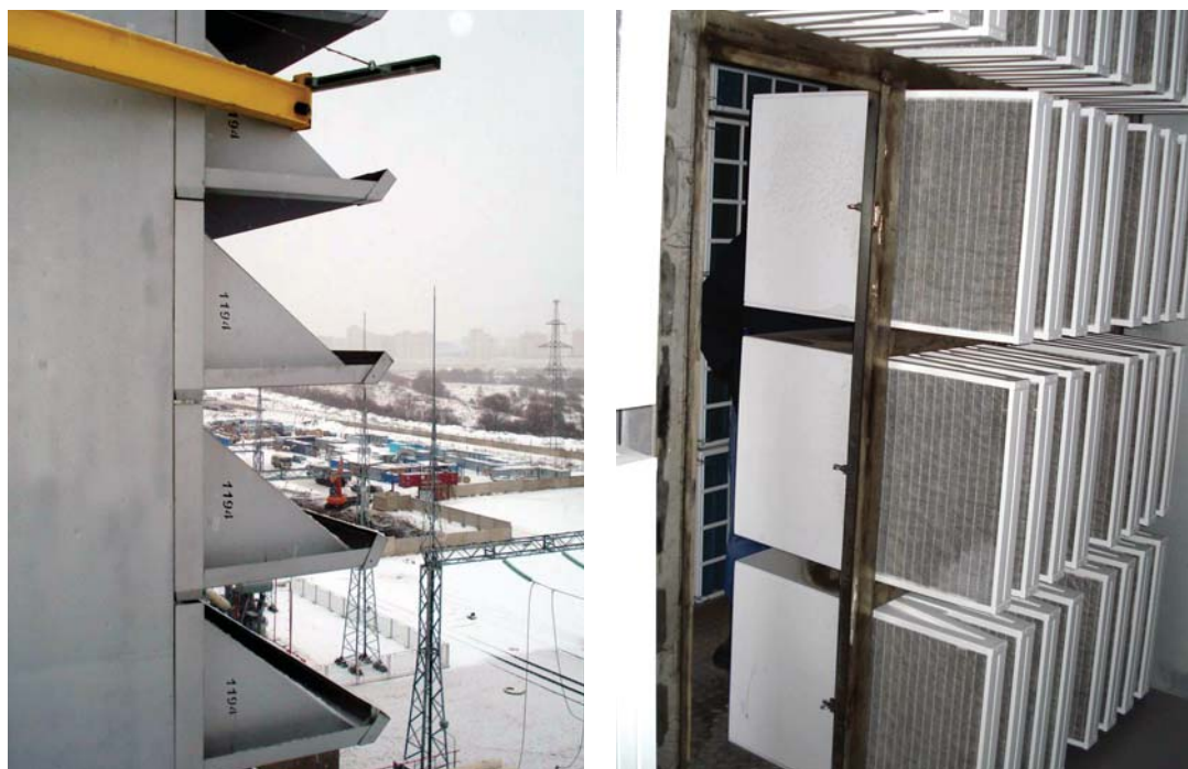
Рис. 1.20. КВОУ ТЭЦ-27: а) погодные козырьки; б) мокрые ФТО (02.02.2008)
