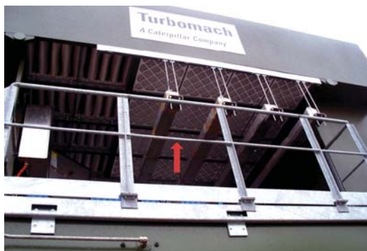
Рис. 2.79. Размещение ИК-обогревателей в КВОУ ГТУ: а) горизонтальное; б) вертикальное [16]
