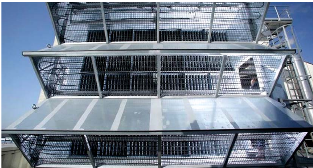
Рис. 2.58. АОС КБОУ ГТУ SolarTaurus70 с саморегулирующимся греющим электрическим кабелем [15]
