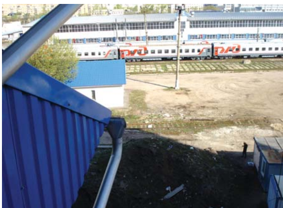
Рис. 5.8. Всас КВОУ ГТУ ориентирован на железнодорожный вокзал
