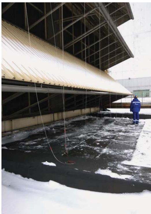
Рис. 2.59. Очистка защитных сеток от птиц и мусора КБОУ стряхиванием
