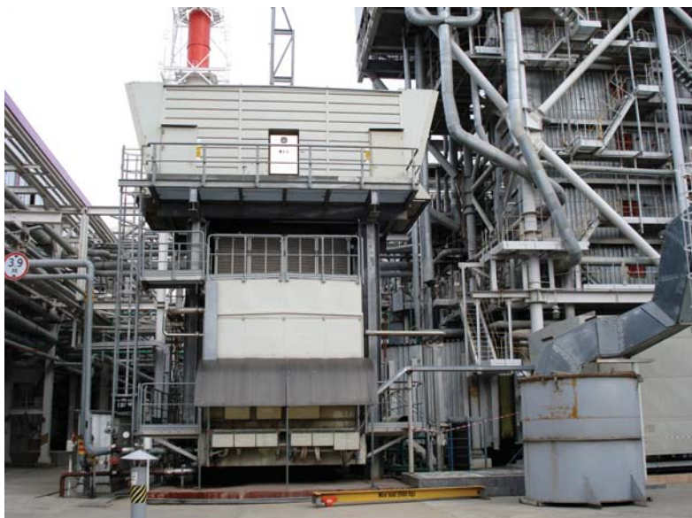
Рис. 2.1. КВОУ ГТУ Siemens GT-10C на Сочинской ТЭС [2]
