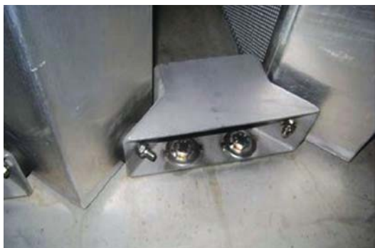
Рис. 3.31. Крепление пластин глушителя шума
