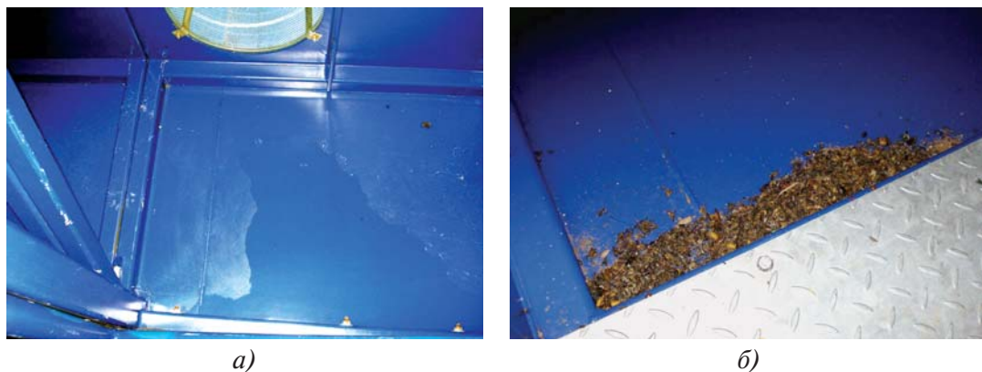
Рис. 1.10. КВОУ ГТУ: а) чистая сторона; б) грязная сторона
