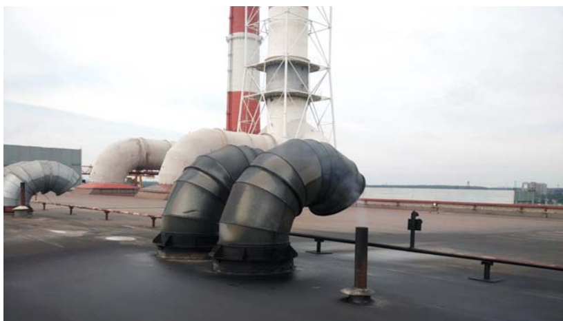
Рис. 5.40. Выпары эксгаустера и промасленная крыша машинного зала
