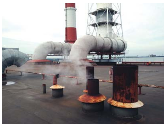
Рис. 5.38. Выпары на крыше машинного зала: а) дренажей турбомашин; б) эксгаустер
