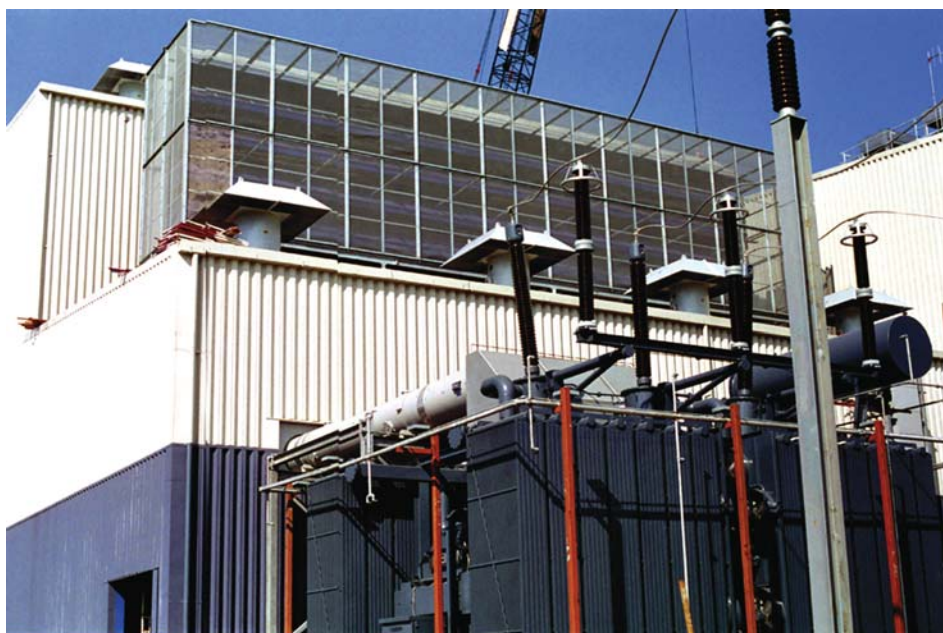
Рис. 2.31. Противомоскитная сетка на ТЭЦ ГТУ в Бангкоке (Таиланд) [9]
