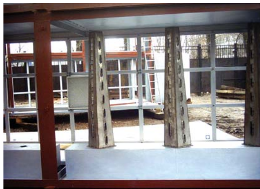
Рис. 1.15. Расположение стоек ПОС и комбисистемы фильтров
