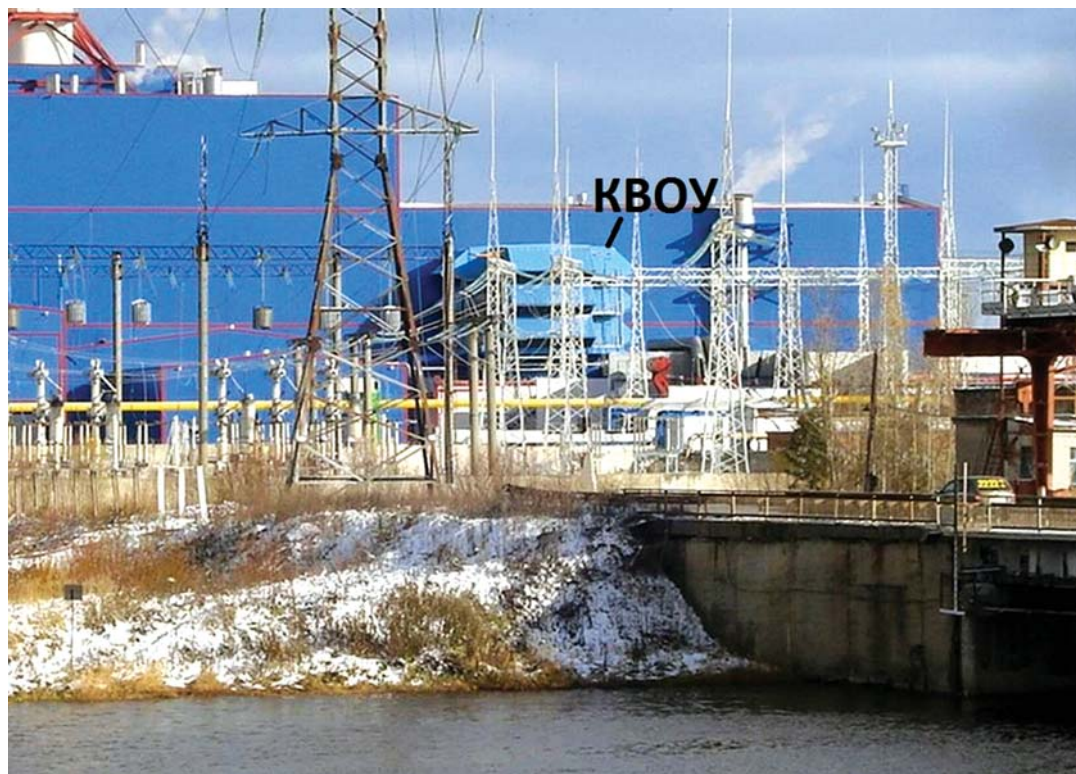
Рис. 2.46. КБОУ ГТУ SGT5-4000F Яйвинской ГРЭС [14]
