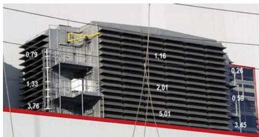
Рис. 5.21. Результаты замеров скорости на всасе КВОУ
