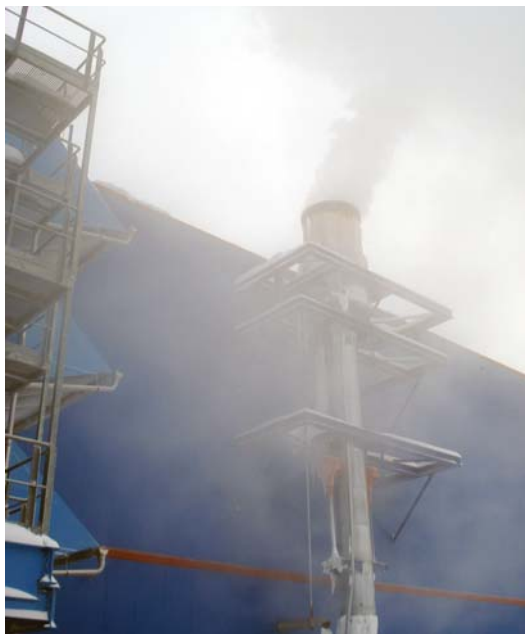
Рис. 2.48. Влажный пар из расширительных дренажей паровой турбины [14]
