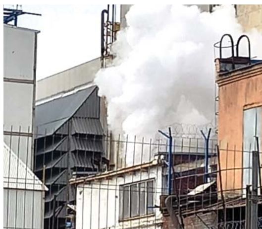
Рис. 2.56. Выпары барботера на всасе КВОУ ГТУ Ansaldo AE64.3A
