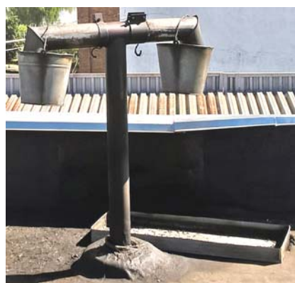
Рис. 5.38. Выпары на крыше машинного зала: а) дренажей турбомашин; б) эксгаустер
