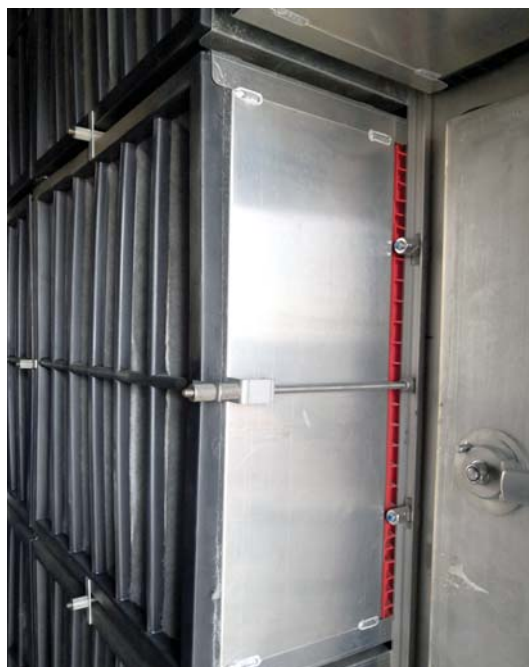
Рис. 3.14. 3D КВОУ с трехступенчатой системой фильтрации и ИК-обогревателями (рис. из буклета компании Freudenberg Filtration Technologies)
