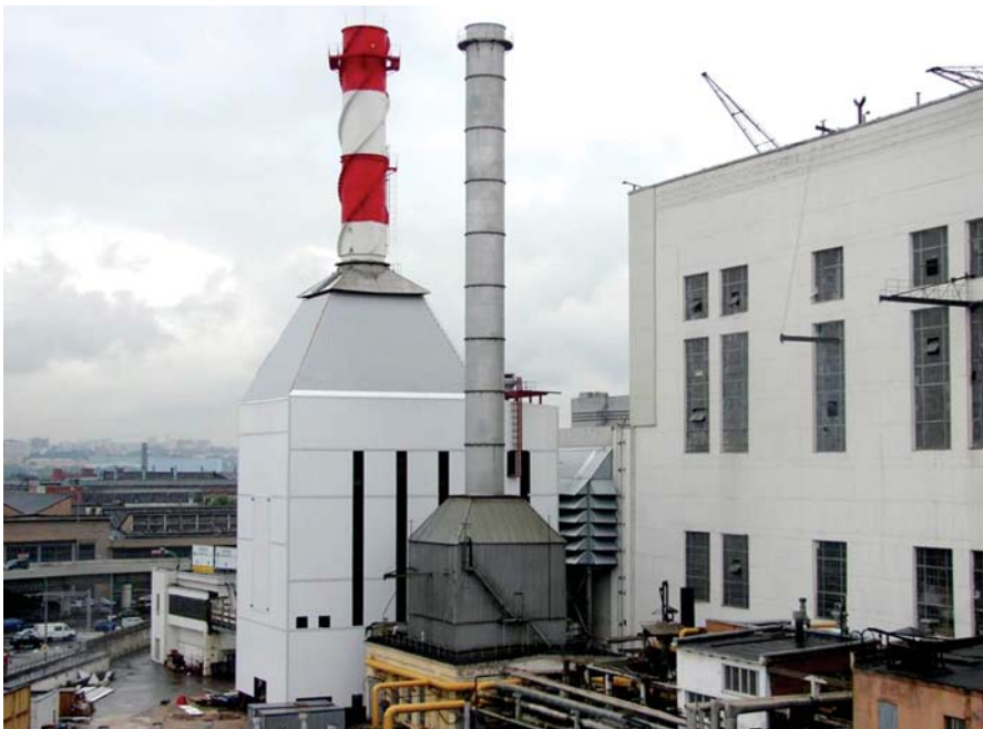
Рис. 5.1. КВОУ ГТУ ТЭЦ-1 в ЮАО перед стеной котла-утилизатора
