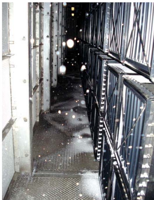
Рис. 2.24. Проникновение снежинок в КВОУ ГТУ
