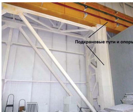
Рис. 5.31. Подкрановые пути и опоры в машинном зале
