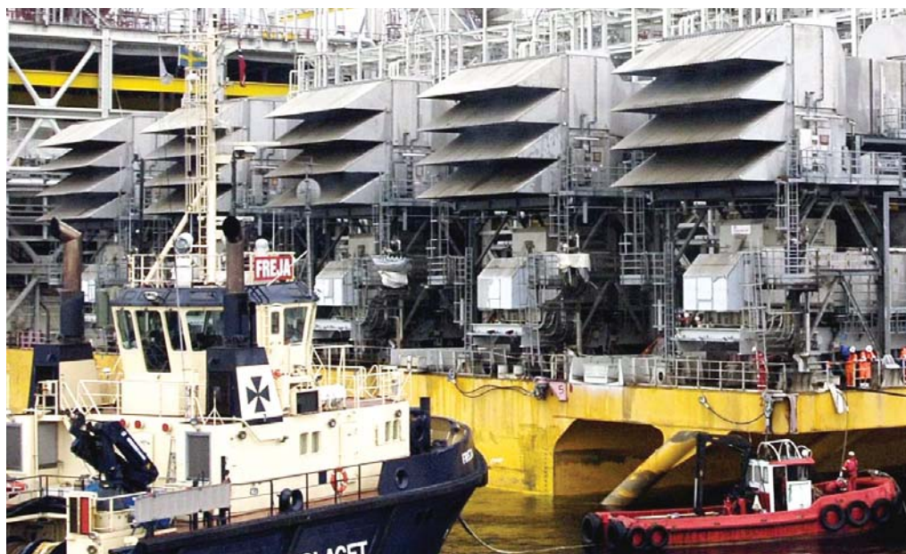
Рис. 2.25. КВОУ ГТУ LM6000 со снеговыми погодными козырьками
