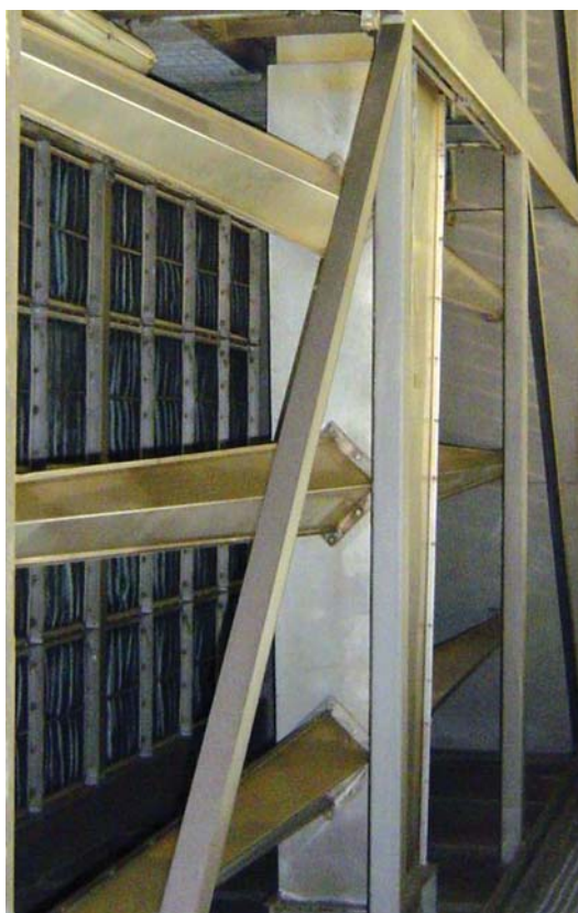
Рис. 2.70. АОС распыла горячего воздуха через горизонтальные стойки
