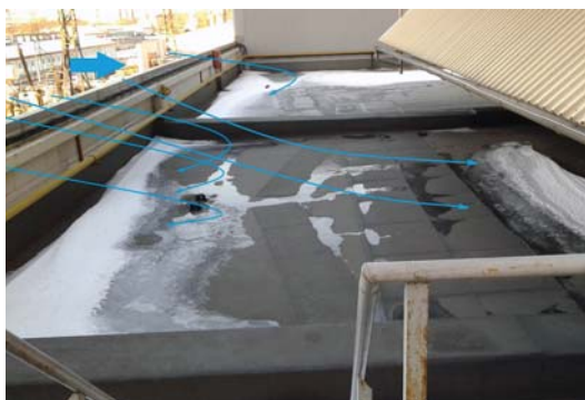
Рис. 5.29. Линии тока основного потока и подветренного вихря
