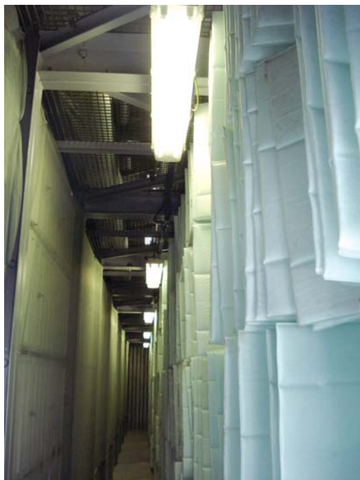
Рис. 3.44. Модуль КВОУ ГТУ, освещение: а) на входе; б) внутри
