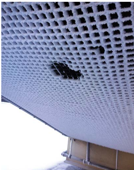
Рис. 2.54. Обмерзание защитной сетки от птиц КВОУ ГТУ
