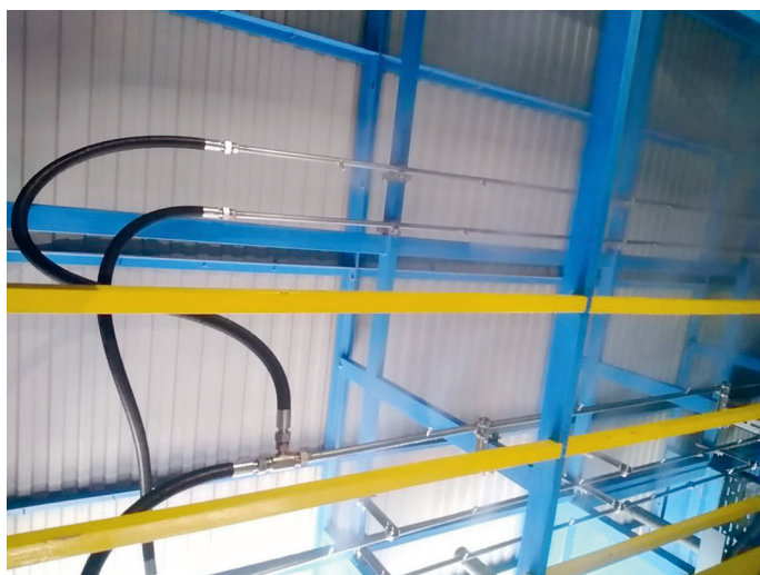
Фото 1.7. Подача воды через форсунки перед воздушными фильтрами КВОУ ГТУ
