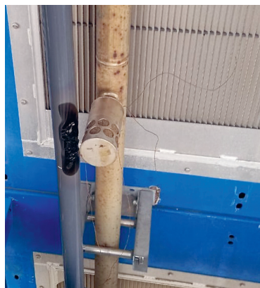
Фото 5.21. Трубы подачи воды в ОУ ИТ ГТУ: а) пластмассовая, повреждена горячим воздухом противообледенителя; б) металлическая
