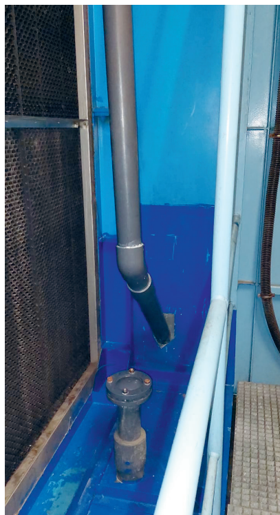
Рис. 5.20. Модернизированная линия дренажа ОУ ИТ
