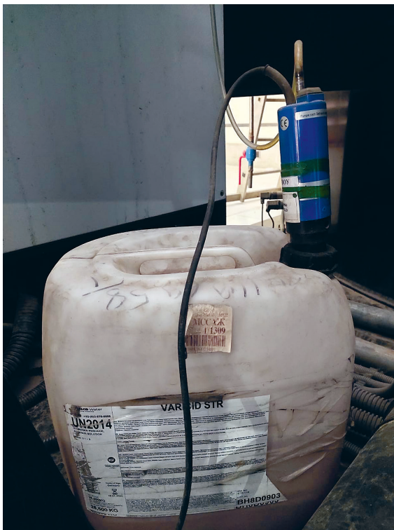
Фото 4.8. Бачок с биоцидом и насосом
