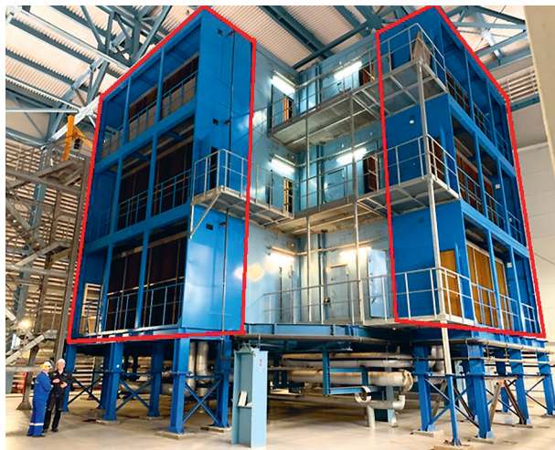
Фото 2.2. Общий вид ОУ ИТ в помещении КВОУ на блоке ПГУ-450 ТЭЦ-3 [1]
