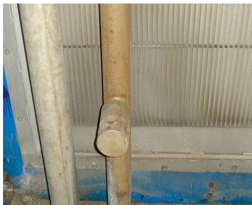
Фото 5.21. Трубы подачи воды в ОУ ИТ ГТУ: а) пластмассовая, повреждена горячим воздухом противообледенителя; б) металлическая
