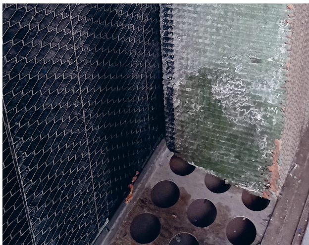
Фото 4.6. Сток воды с кассет в поддоны
