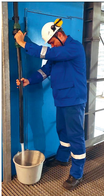
Фото 5.14. Проливка труб орошения ОУ ИТ цикловой водой
