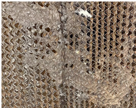
Фото 7.20. Сильное загрязнение МСУ И-кассет
