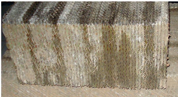
Фото 5.4. Неравномерное орошение испарительных кассет ОУ ИТ
