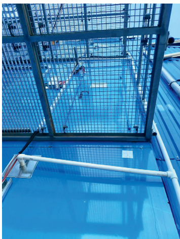
Фото 5.16. Трубопроводы проливки системы орошения ОУ ИТ
