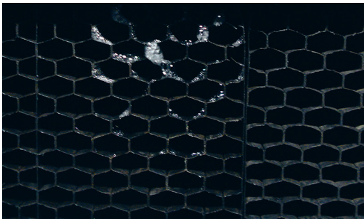
Фото 7.11. Неэффективная сепарация влаги каплеуловителем: а) протечки воды через каплеуловитель; б) следы влаги на корпусе фильтра тонкой очистки класса F8, установленного реверсно к финишному фильтру класса E10
