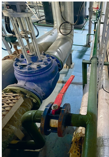
Фото 5.11. Врезка подачи умягченной воды на ОУ ИТ
