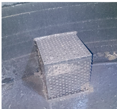
Фото 4.7. Сетчатый фильтр в блоке фильтров бака (фото изнутри бака)
