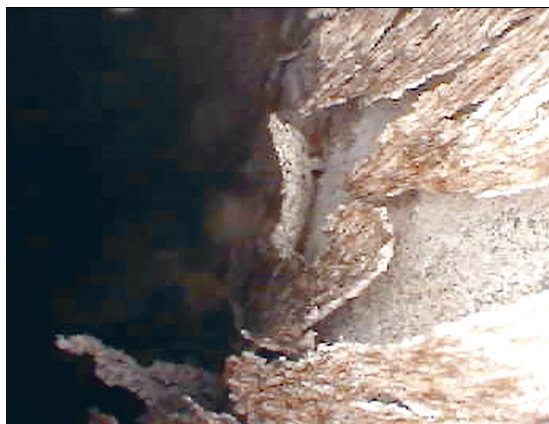
Фото 5.8. Отложения в трубе дренажа ОУ ИТ
