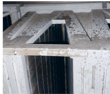
Фото 7.11. Неэффективная сепарация влаги каплеуловителем: а) протечки воды через каплеуловитель; б) следы влаги на корпусе фильтра тонкой очистки класса F8, установленного реверсно к финишному фильтру класса E10
