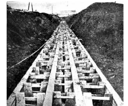
1-я ТЭЦ МОГЭС. Трехтрубные каналы к Шарикоподшипникстрою в опалубке.
