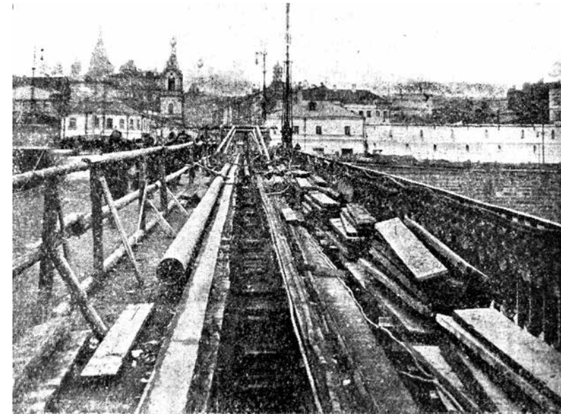
Теплофикация Центрального района Москвы. Прокладка теплопроводов через Замоскворецкий мост.
