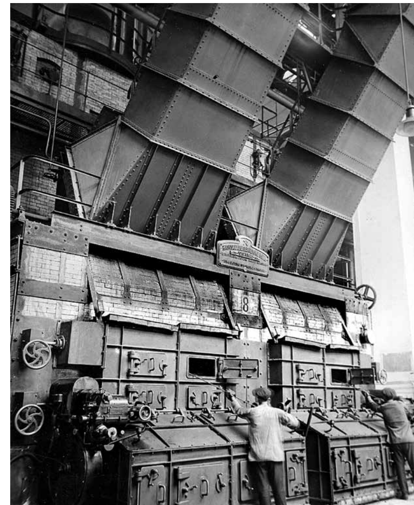
Шатурская ГРЭС. Котел, отапливаемый торфом.
