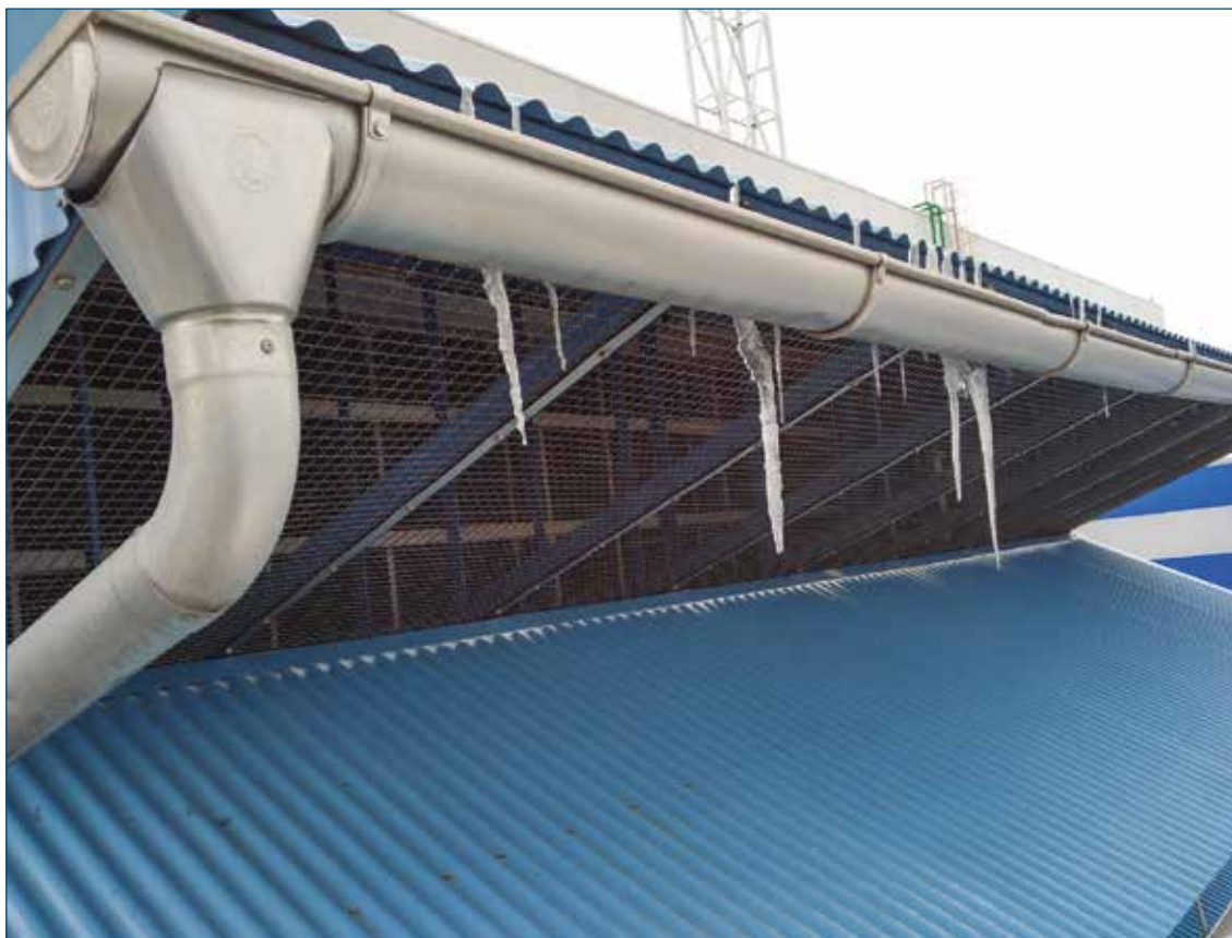
Рис. 14. Сосульки на погодных козырьках КВОУ ГТУ
