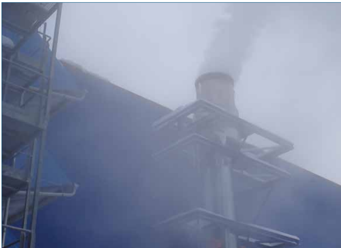
Рис. 8. Влажный пар из расширительных дренажей паровой турбины
