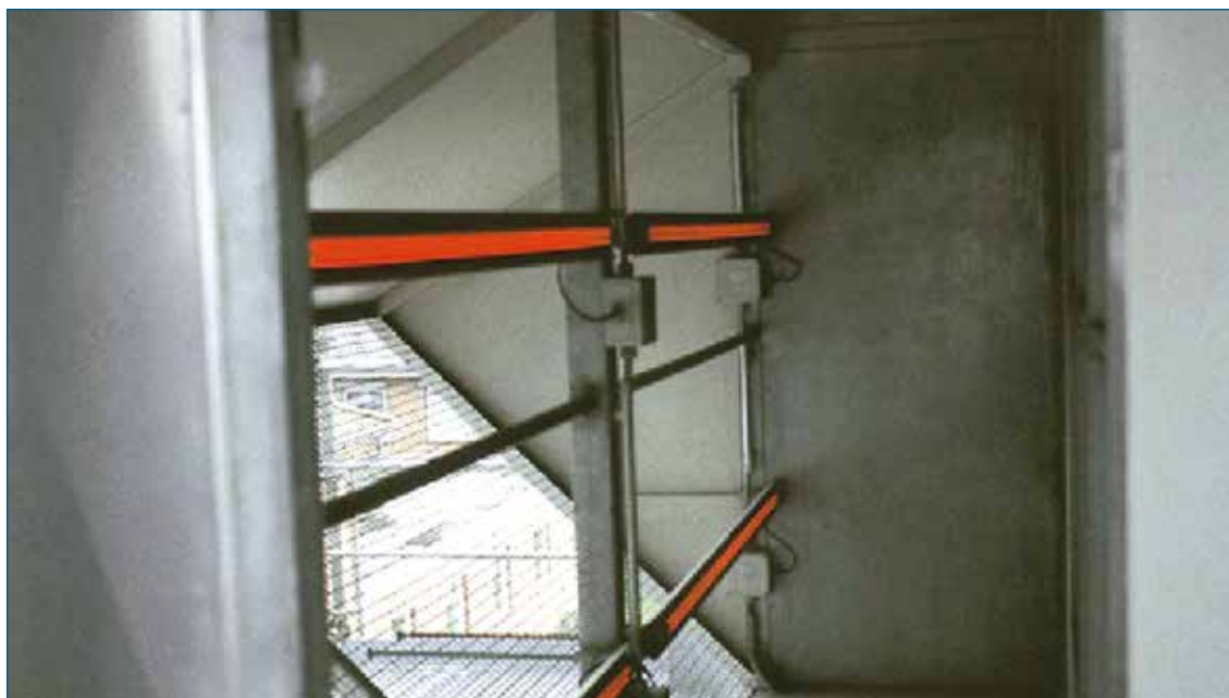
Рис. 19. ИК-обогреватели для предотвращения заноса снегом фильтров первой ступени КВОУ ГТУ
