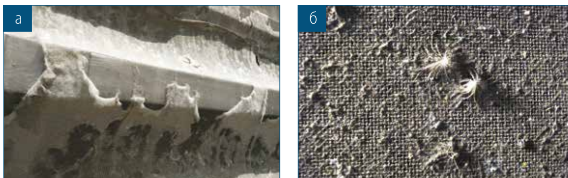
Рис. 6. Интенсивность заноса противомоскитных сеток: а – тополиным пухом; б – несгоревшими углеводородами и одуванчиками
