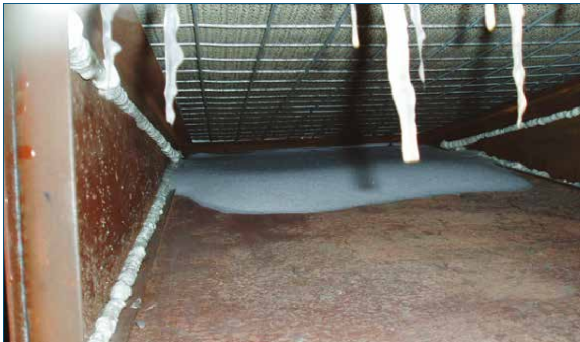
Рис. 4. Лед и снег на фильтрах грубой очистки КВОУ ГТУ
