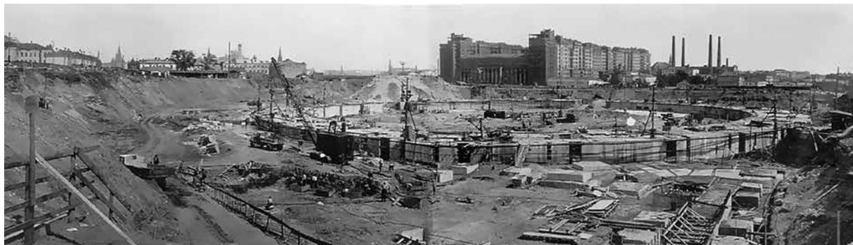
На строительстве Дворца советов укладывается сейчас бетонное основание будущего амфитеатра – большого зала. Главный фундамент уже закончен. Он образовал два железобетонных кольца диаметром в 140–160 м. В этом году будут построены фундаменты главного вестибюля, входа и фойе. Нужно будет уложить 140 тыс. м<sup>3</sup> бетона. На фото: панорама строительства.
