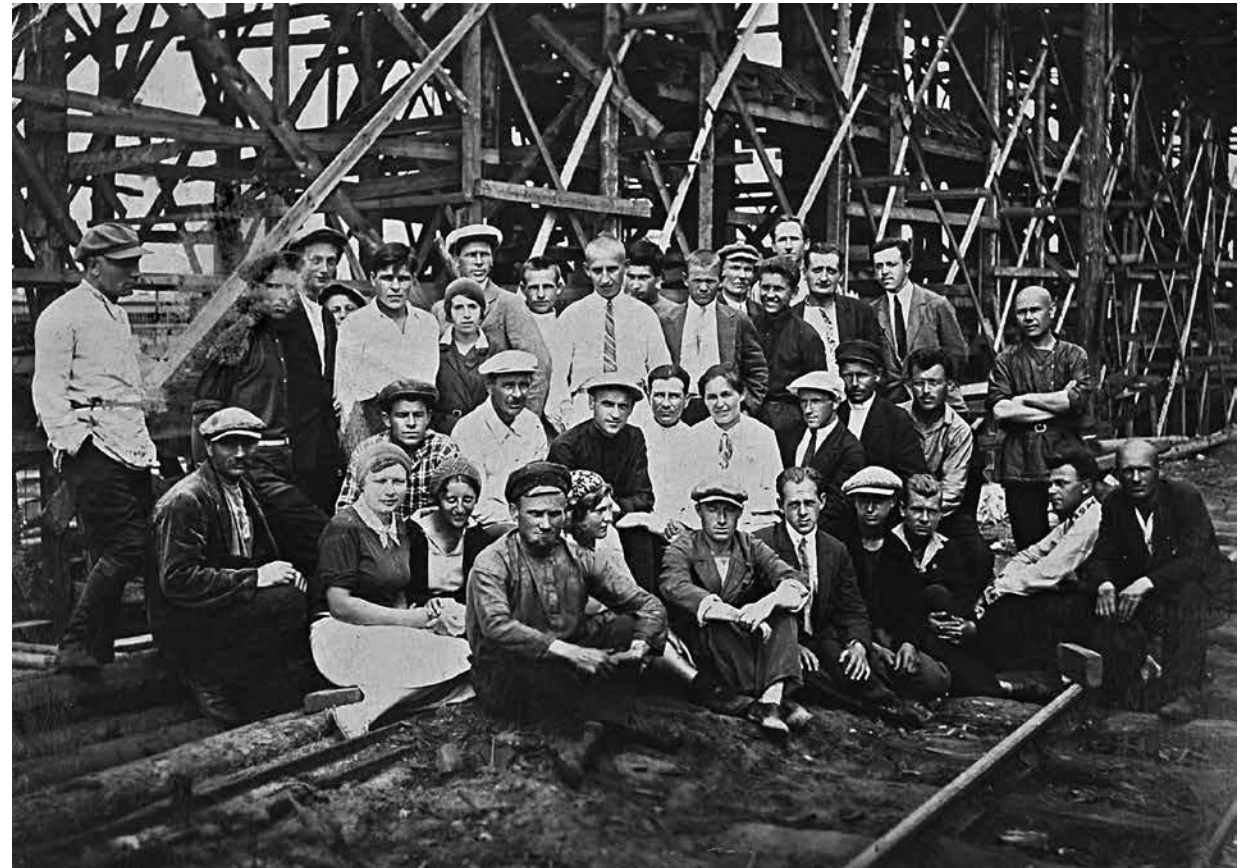
Первые строители Фрунзенской ТЭЦ.
