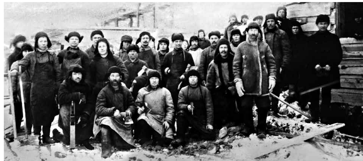
Бригада плотников Сталинской ТЭЦ.
