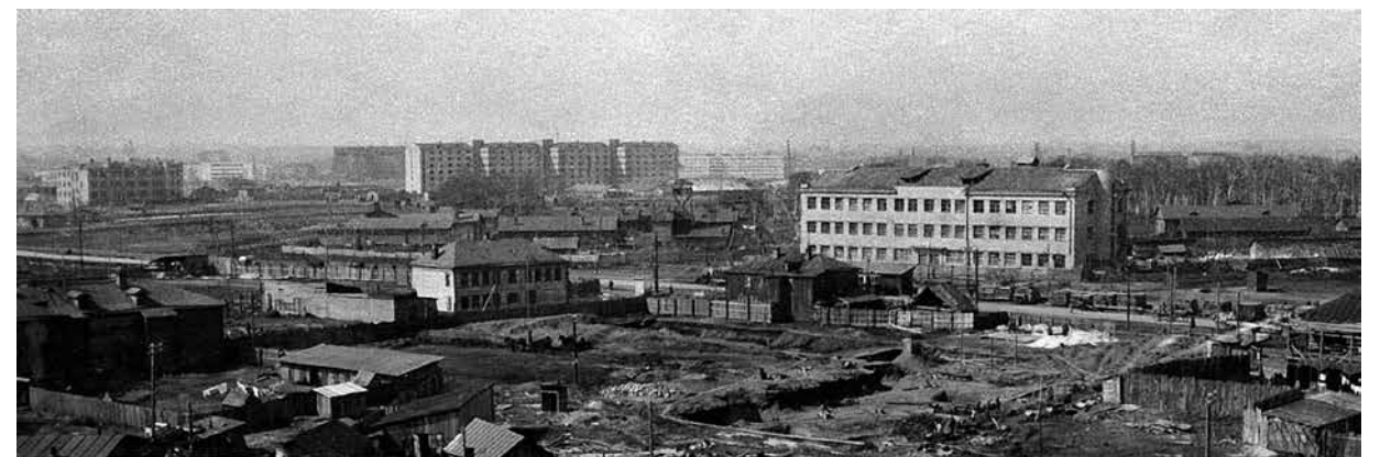
Панорама строительства Сталинской ТЭЦ. Начало земляных работ под фундамент первой градирни.
