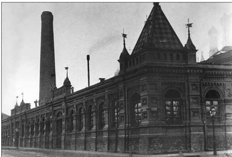
Рис. 1. Здание Георгиевской электростанции. Фотография. 1890-е гг. Архив Музея Мосэнерго. Фонд 8. Ед. хр. 1. Ф_05
