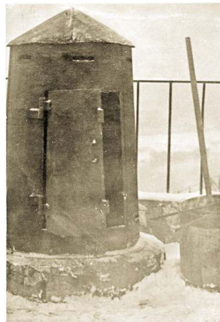
Индивидуальные будки для защиты дежурного персонала электростанций от осколков при бомбежках
