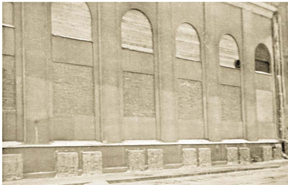
Окна ГЭС-1, заложённые кирпичом и досками для защиты от осколков при бомбежках
