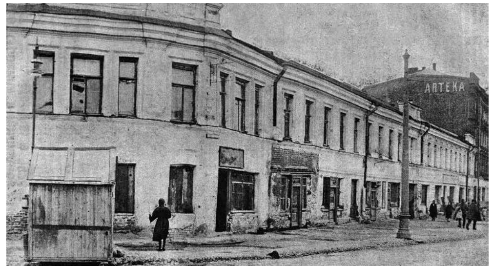
Дом на углу Кожевнического вражка № 12. В этом доме много частных магазинов: красильня и химчистка, бараночная, булочная и т. п. О восстановлении дома никто из засевших там нетрудовых элементов не заботится. Дом даже не поддерживается в порядке. Мало-помалу жилые помещения разрушаются. Штукатурка обваливается, тротуары в угрожающем состоянии. Во дворе грязь. Так содержатся дома теми, кто небрежно относится к общенародному достоянию, заботясь лишь о личной выгоде.
