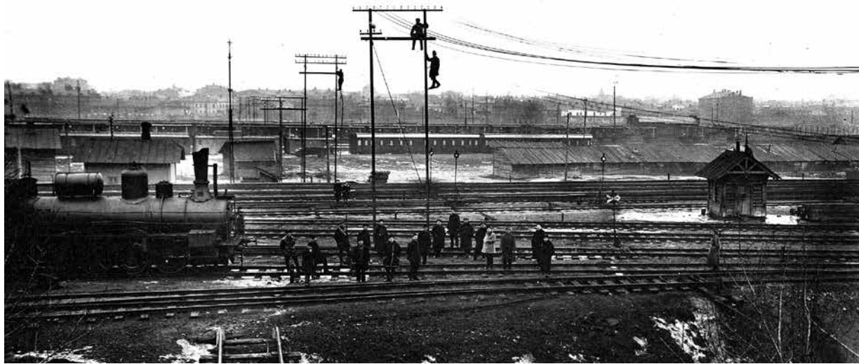
Монтаж через ж.-д. пути высоковольтной сети, идущей из Каширы. 1920-е гг.
