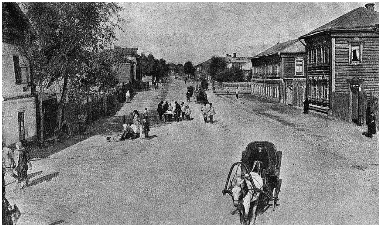
Вновь устроенная булыжная мостовая на окраине города, в Дубровках, по Угрешской улице. В этой местности раньше не было мостовых совсем, осенью и весной проход пешеходов и проезд на экипажах был едва возможен.
