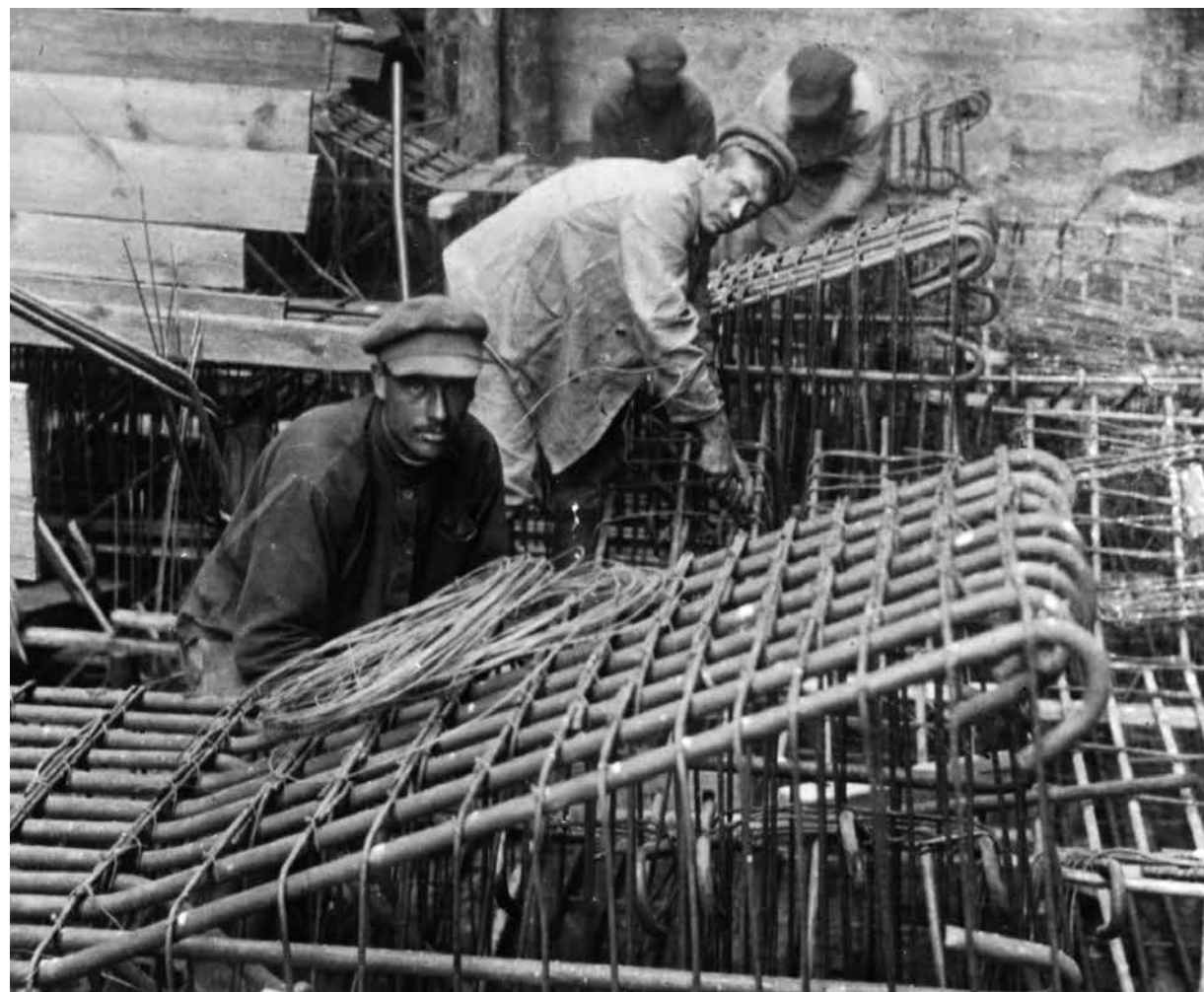
Монтаж арматуры под железобетонное основание.
