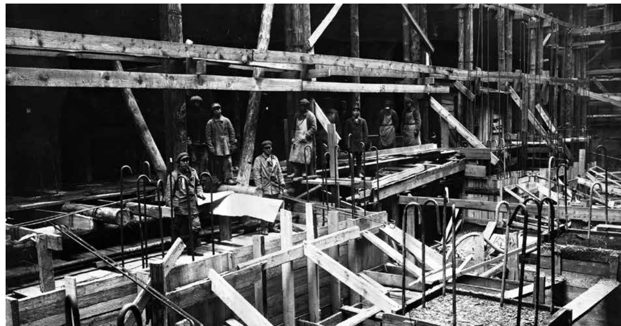
Закладка фундамента опор под котлы Гарбе 750 м 2 .
