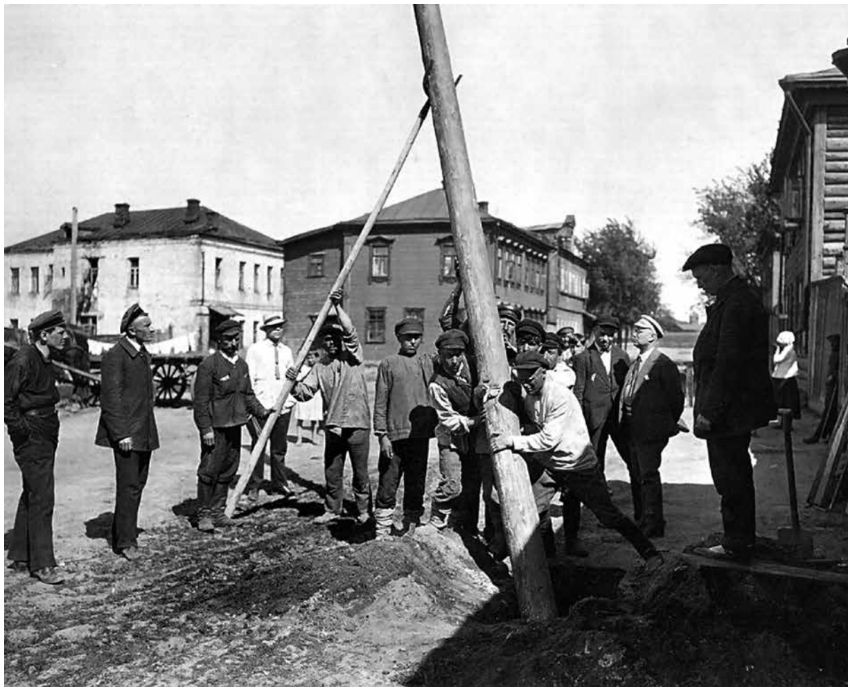
Электрификация рабочих окраин. Установка столба.
