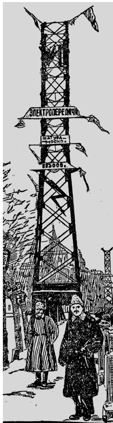
Башня для воздушных проводов для передачи тока напряжением 115 000 В с Шатурстроя.
