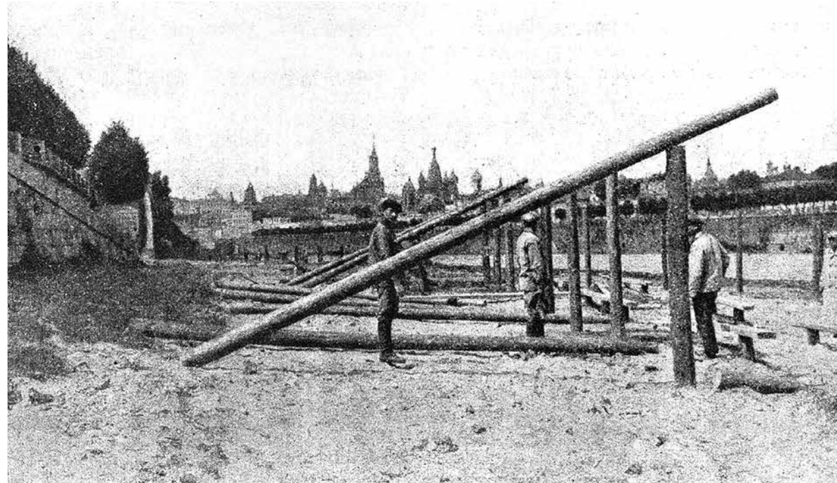
Работы по устройству купален на берегу Москвы-реки по Раушской набережной.
