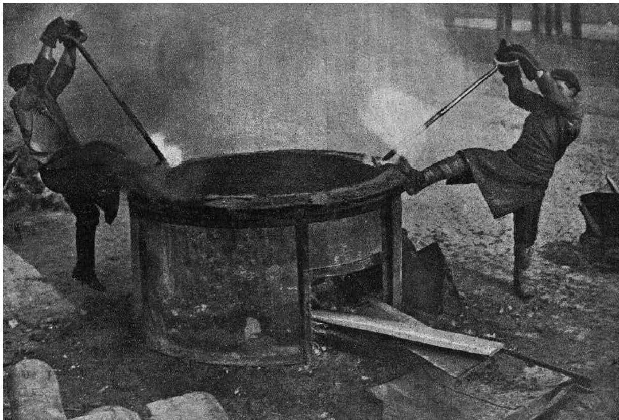
Плавка асфальта.
