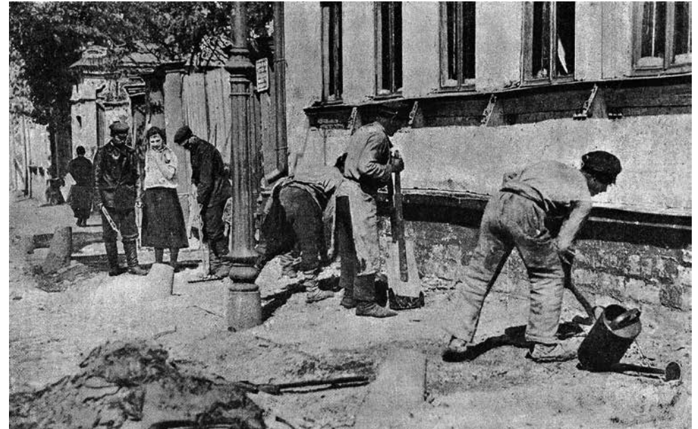
Работы по ремонту дома № 17 по Б. Полянке. Дом этот населен исключительно рабочими — четыре квартиры, всего 28 человек. Жильцы взяли ссуду в Горбанке и производят наружный и внутренний ремонт дома. Дом уже почти отремонтирован, также и тротуар. Сейчас пробуждена широкая инициатива трудового населения Москвы к работе по восстановлению и сохранению жилой площади.
