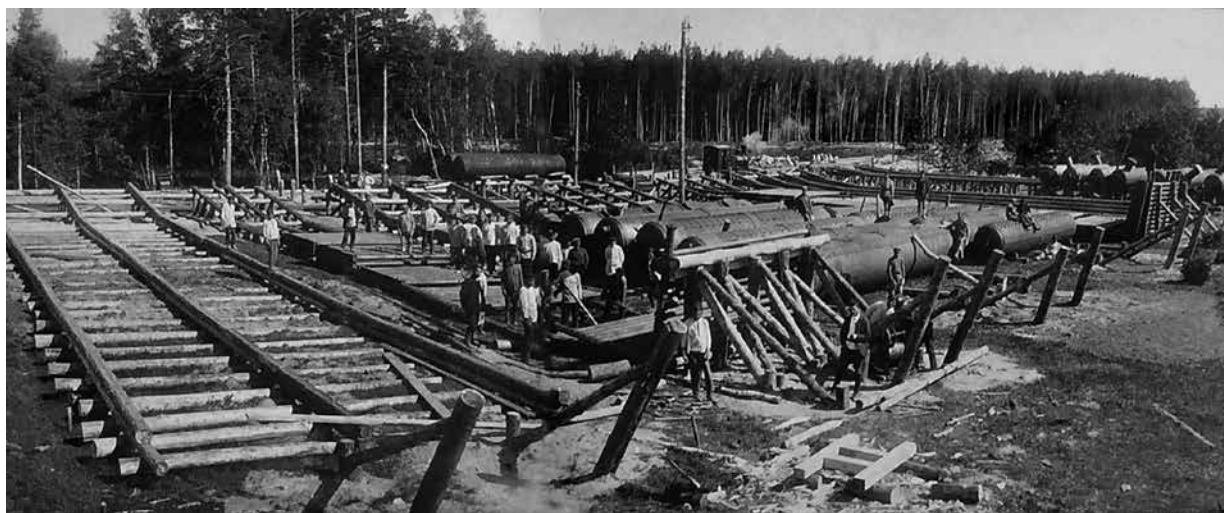
Прибытие котельного оборудования.
