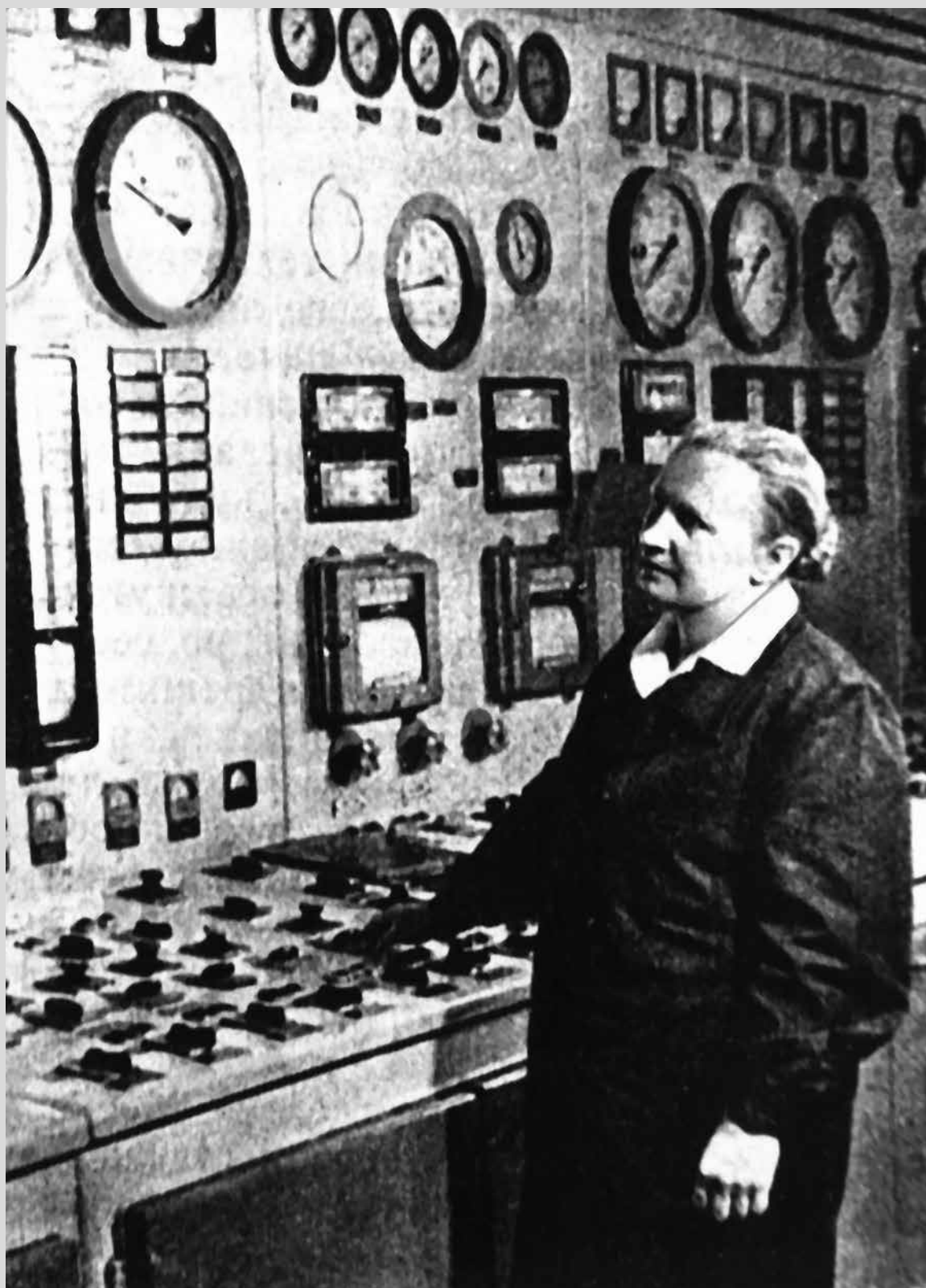
К.А. Перевезенцева – первая в системе Мосэнерго женщина-машинист, принявшая саратовский газ в топки МГЭС-1 и МГЭС-2, 1946 год
