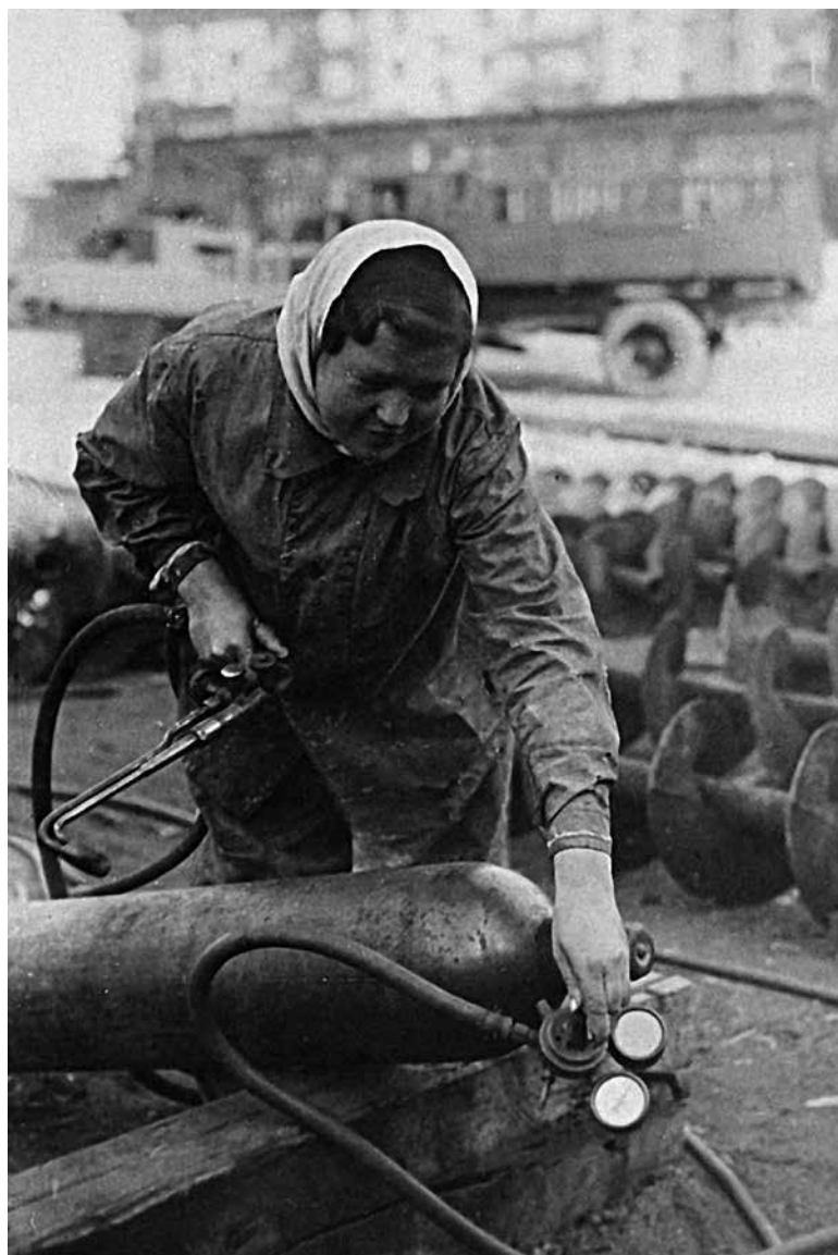
Подрезка спирали шнека, ТЭЦ-7
