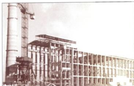
ТЭЦ-21 строится TEP-21 under construction
