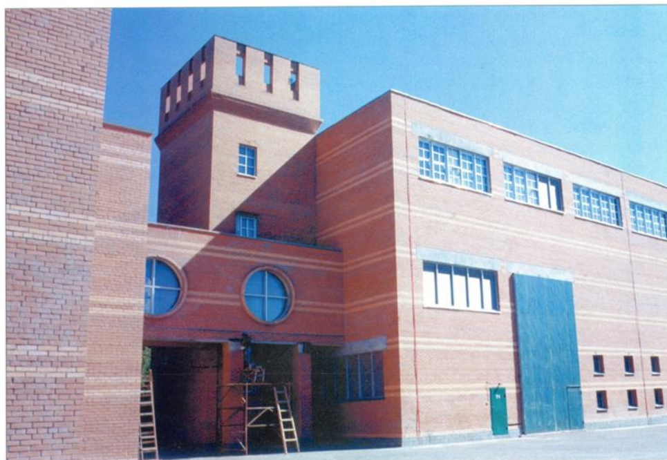
Электроподстанция закрытого типа / Closed-type substation
