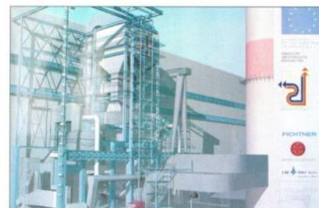
Каталитическая установка DeNOx на ТЭЦ-21 DeNOx plant at TEP-21
