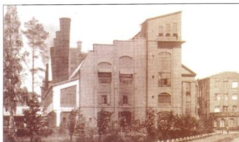
Станция "Электропередача" (20-е годы) «Elektroperedacha» power station (1920-ties)
