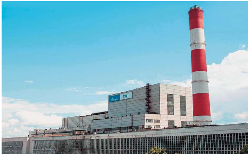
Главный корпус ТЭЦ-11, 2013 год
