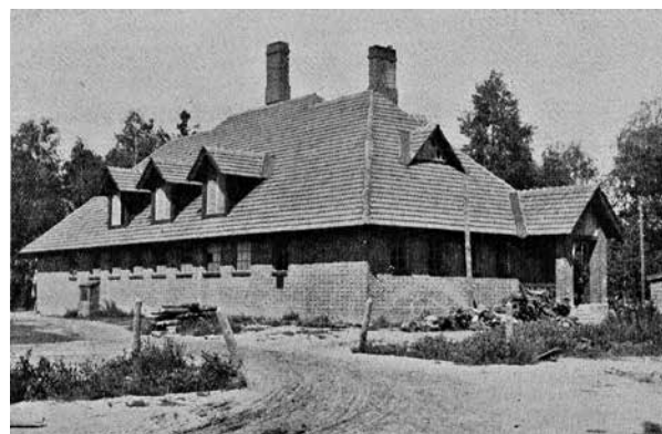
Здание бани для рабочих при Шатурской станции им. В.И. Ленина.
