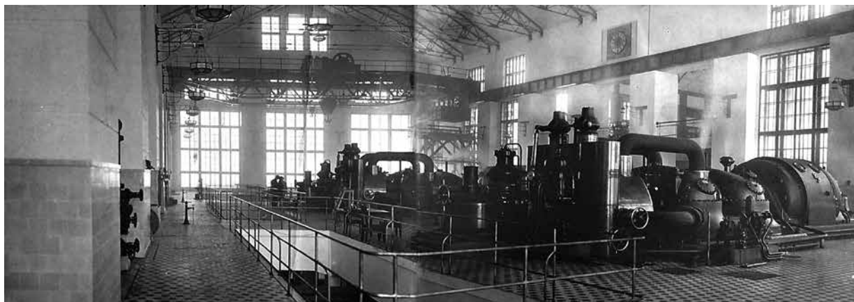
Машинный зал № 1 Шатурской ГРЭС.
