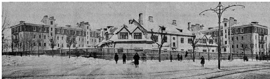
Рабочее жилищное строительство. На первом плане тип облегченного (термолитового) строительства 1924 г. На втором: корпуса капитального строительства сезона 1925 г.
