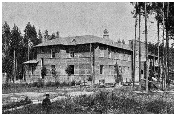
Здание больницы при Шатурской станции им. В.И. Ленина.
