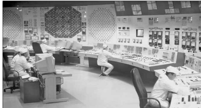
Рис. 6. Блочный щит управления
