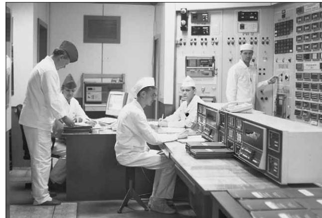
Рис. 8. Щит дозиметрического контроля
