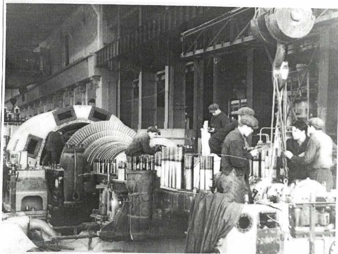
Монтаж турбоагрегата на ТЭЦ №20 Мосэнерго.
