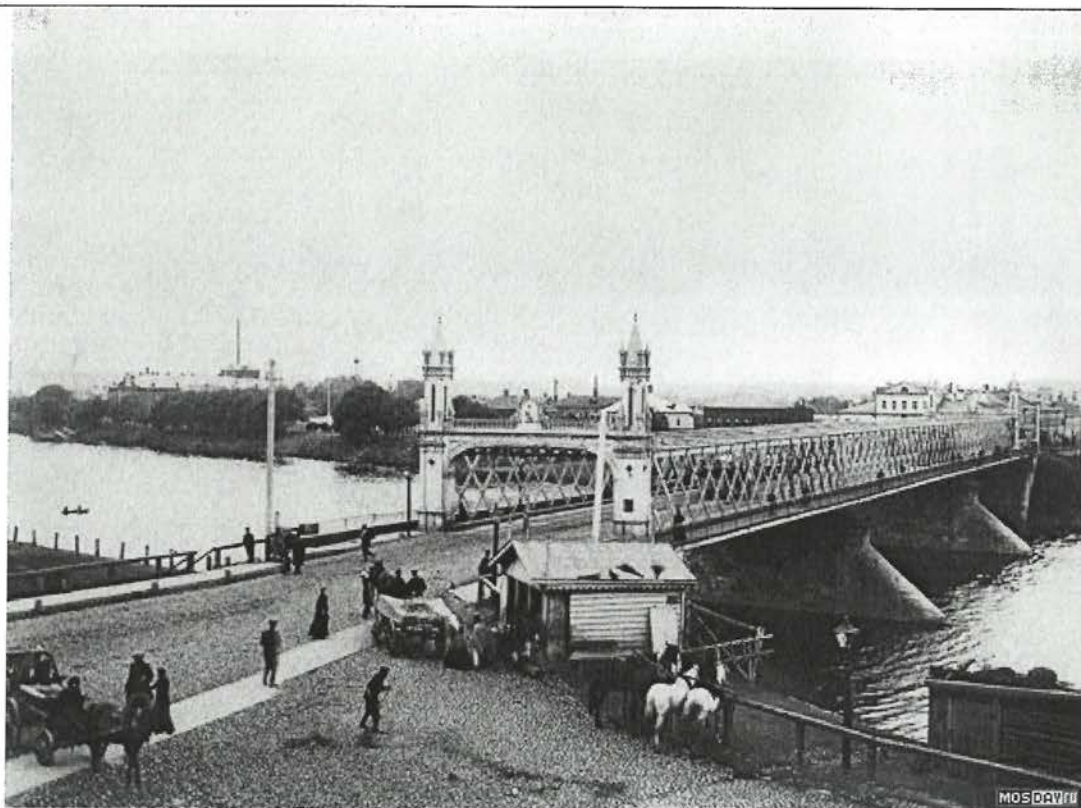
Старый Крымский мост. За ним, на противоположном берегу с земляными откосами в разрыве между деревьями виден наш дом. 11
