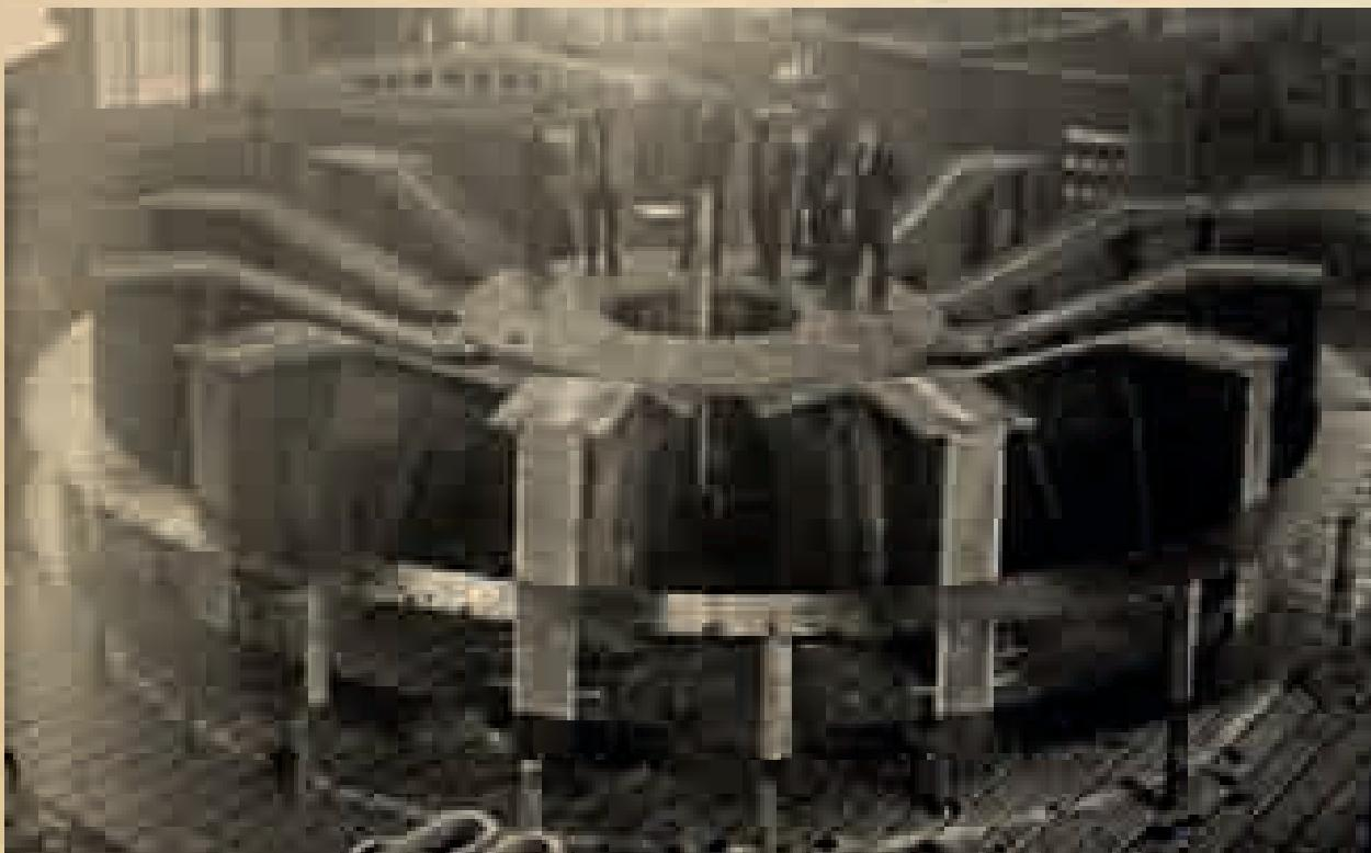
Рыбинская ГЭС, сборка ротора гидротурбины, 1941 год
