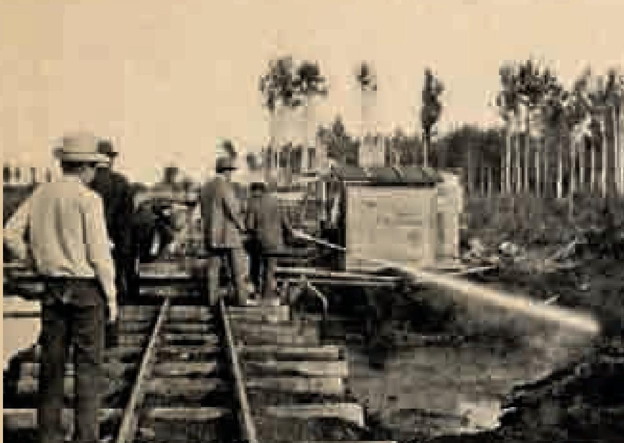
Р.Э. Классон на испытаниях гидроторфа, 1915 год
