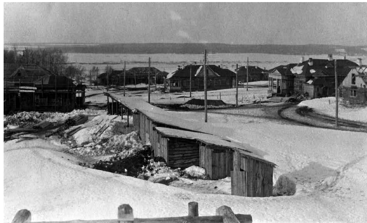
Строящийся поселок Каширстрой. Ок. 1919 г.
