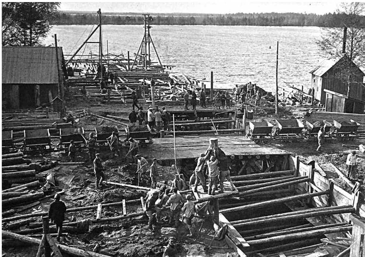
Строительство приемного канала в Черное озеро.
