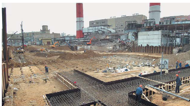
Армирование нижнего строения фундамента главного корпуса, апрель 2012 года
