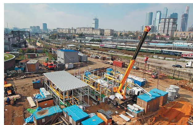
Строительство дожимных компрессорных установок, сентябрь 2013 года
