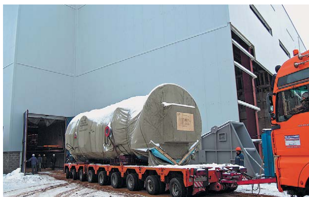
Разгрузка газовой турбины ГТЭ-160, март 2013 года
