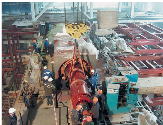
Установка ротора паровой турбины, апрель 2013 года
