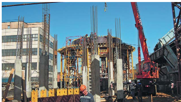
Строительство узла нейтрализации, апрель 2012 года
