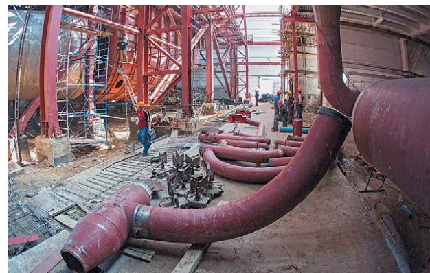
Монтаж трубопроводов в котельном отделении, июнь 2013 года
