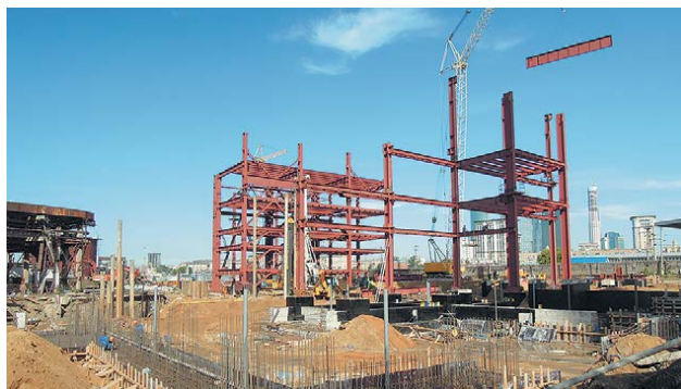
Строительство главного корпуса, июль 2012 года
