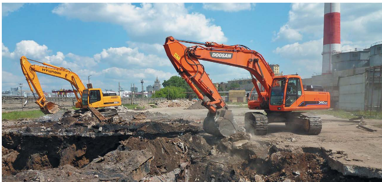
Начало строительства главного корпуса ПГУ-220 ТЭЦ-12, май 2011 года
