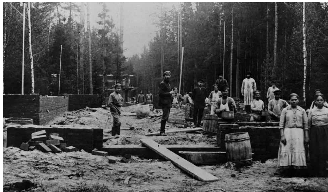
Траншея под фундамент временной станции.
