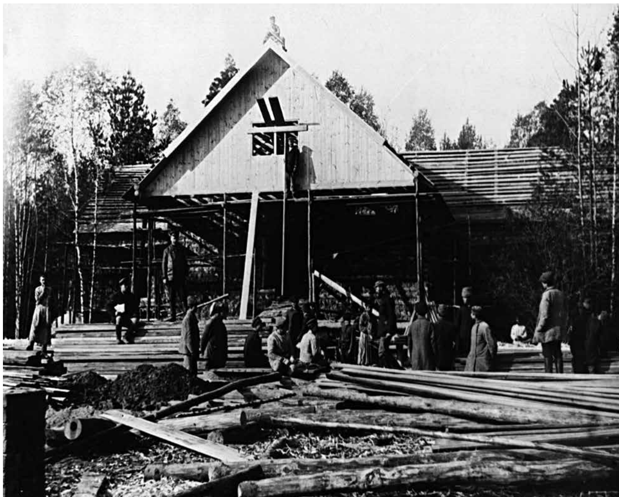
Первая стройка на Черном озере.
