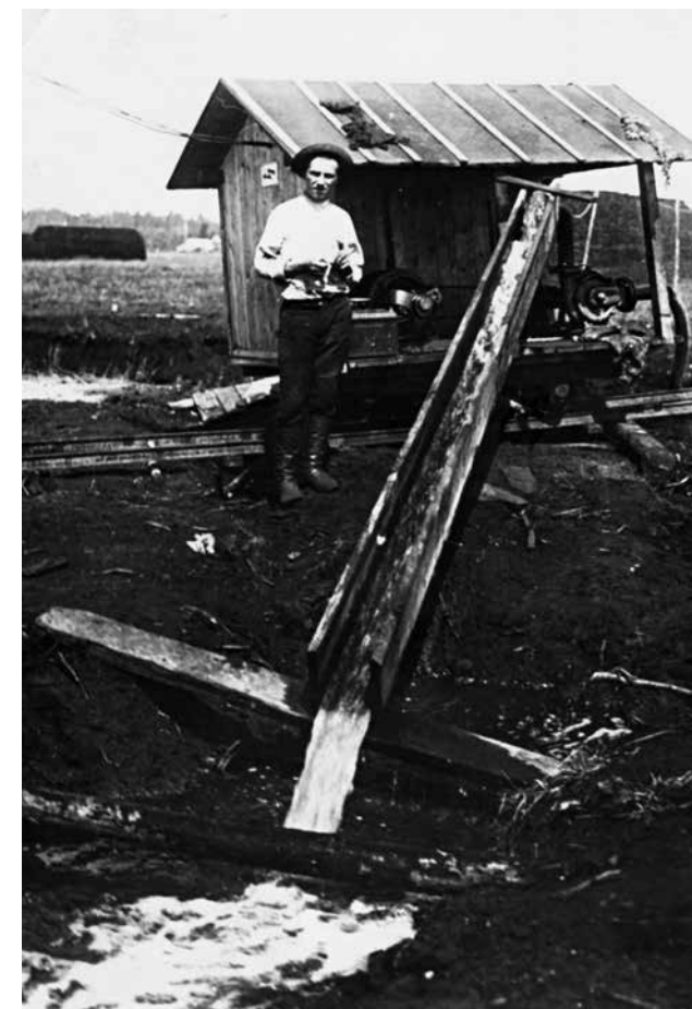
Откачка воды с торфяного поля.
