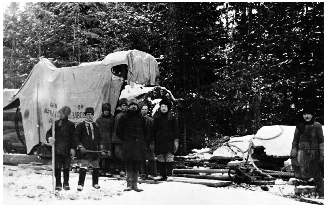
Прибытие на станцию ротора турбогенератора.
