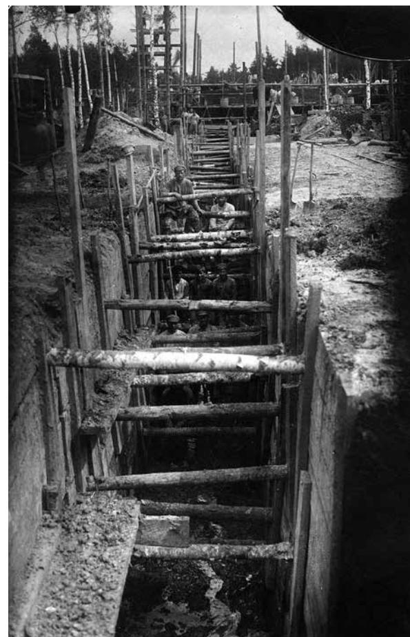
Траншея под фундамент временной станции.
