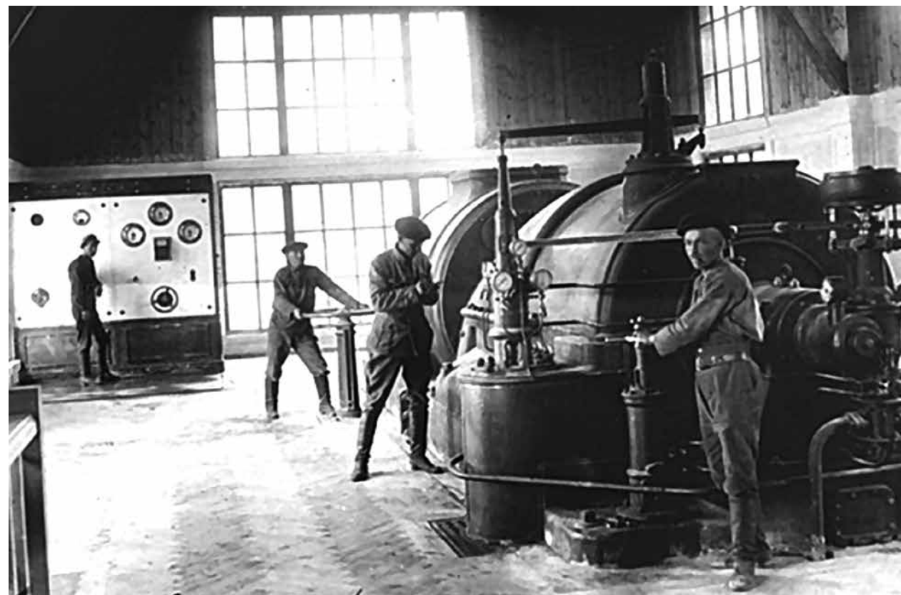
Машинный зал с турбиной Эрликон 5000 кВт. Фото Н. Степанова.
