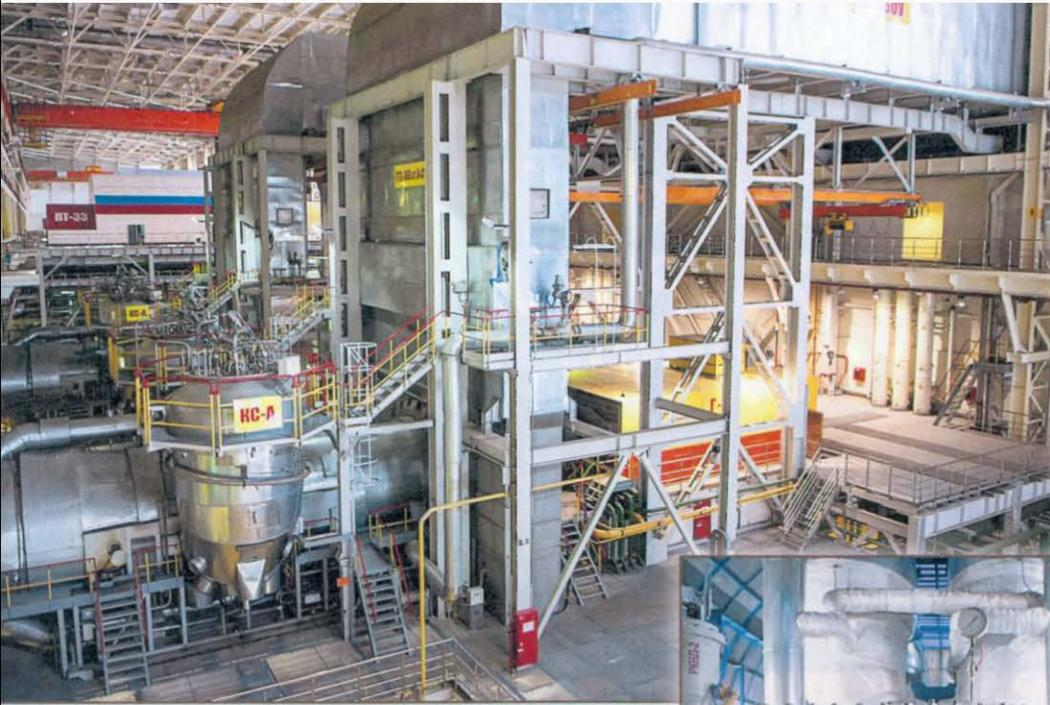
Так выглядит **ТУРБИННЫЙ ЗАЛ** (вверху). На переднем плане газовая турбина с камерой сгорания газа (буквы «КС»). Она крутит генератор (жёлтый). На заднем плане видна паровая турбина (буквы «ПТ»). Под защитным кожухом она укутана теплоизоляционным материалом (справа).
