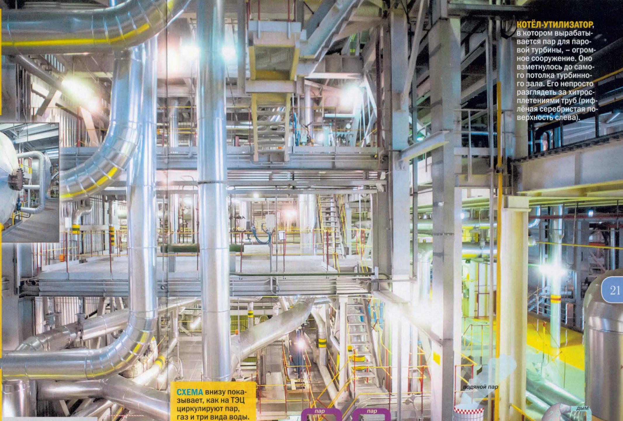
**КОТЁЛ-УТИЛИЗАТОР**, в котором вырабатывается пар для паровой турбины, – огромное сооружение. Оно взметнулось до самого потолка турбинного зала. Его непросто разглядеть за хитросплетениями труб (рифлёная серебристая поверхность слева).
