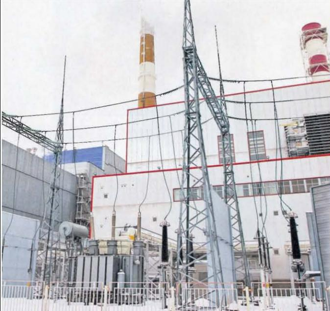
**ТРАНСФОРМАТОРЫ** увеличивают электрическое напряжение генераторов с 10 тысяч до 220 тысяч вольт. Чем выше напряжение, тем меньше потери электроэнергии при передаче её по проводам на большие расстояния.
