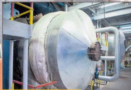
Этот цилиндр – **ПОДОГРЕВАТЕЛЬ СЕТЕВОЙ ВОДЫ**. Здесь пар из теплофикационного отбора отдаёт тепло сетевой воде, которая поступает в батареи домов. Зимой воду нагревают до 130 градусов. Отдав тепло, она возвращается на ТЭЦ с температурой 60 градусов (чтобы в мороз не замерзла тепломагистраль)
