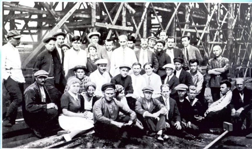
Первые строители ТЭЦ-12. 1932г.
