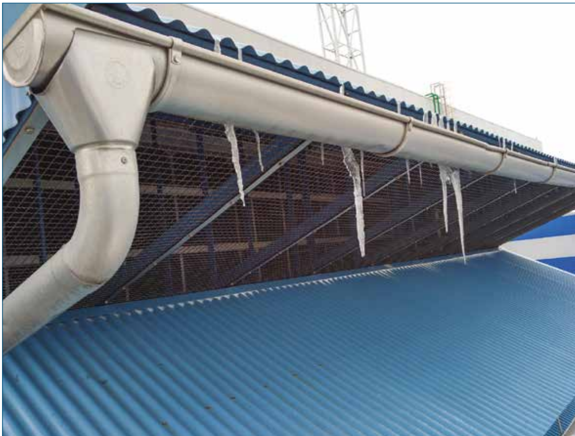
Рис. 14. Сосульки на погодных козырьках КВОУ ГТУ
