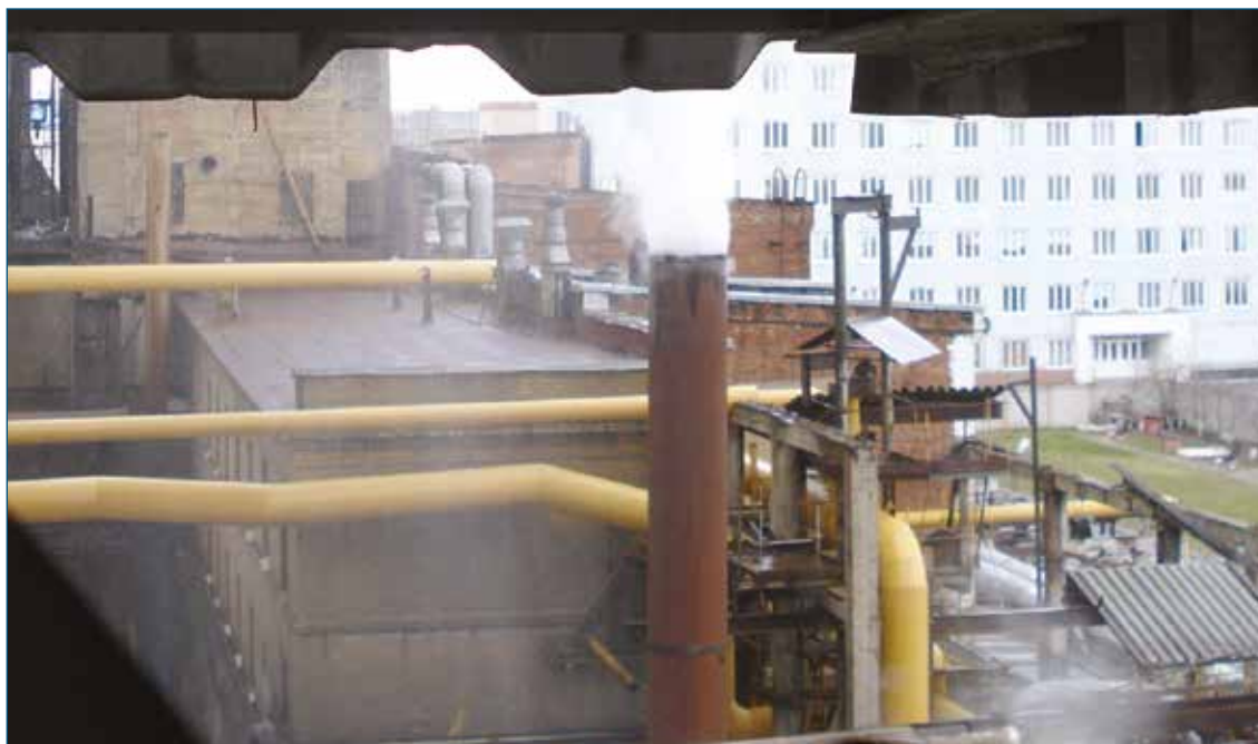
Рис. 15. Выпары барботера на всасе КВОУ ГТУ
