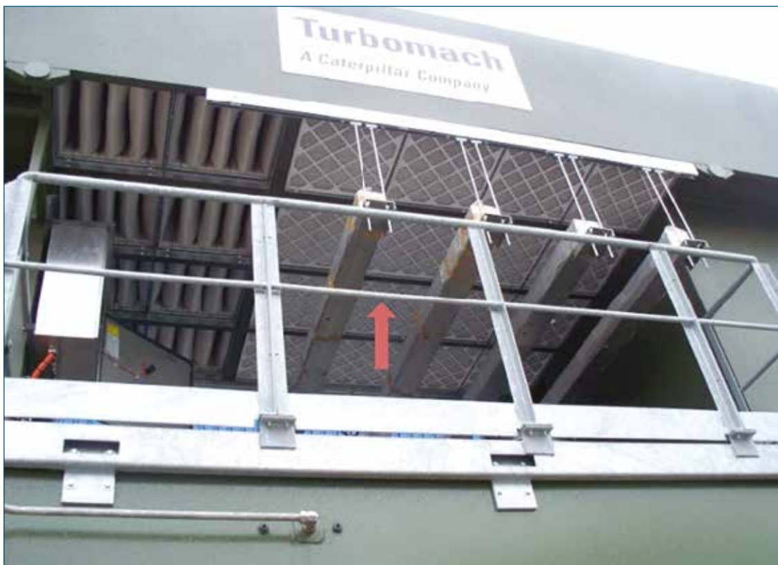
Рис. 20. Вертикальное размещение ИК-обогревателей в КВОУ ГТУ
