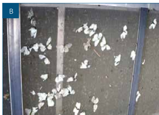
Рис. 4. Штатные противомоскитные сетки: а – чистые; б – покрытые тополиным пухом; в – покрытые бабочками
