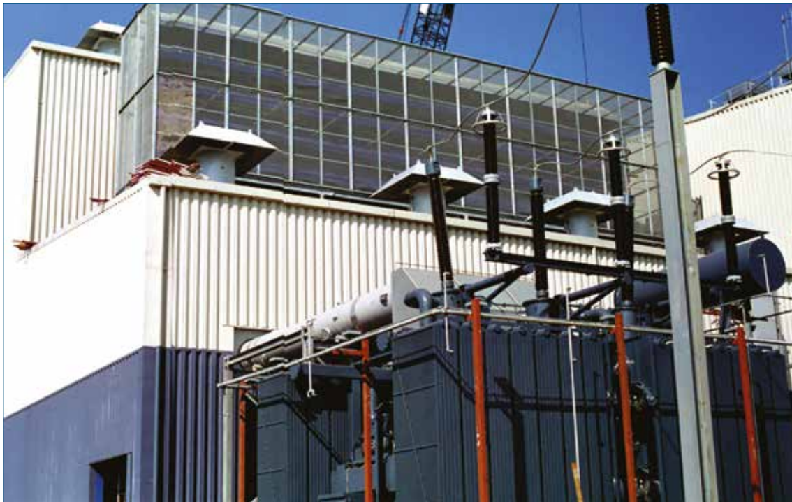
Рис. 1. Противомоскитная сетка на ТЭЦ ГТУ в Бангкоке (Таиланд)
