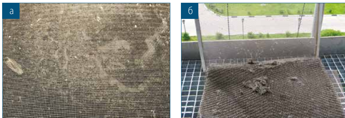
Рис. 11. Отложение загрязнений внутри двуслойных противомоскитных сеток: а – сетка в сборе; б – сетка разобрана
