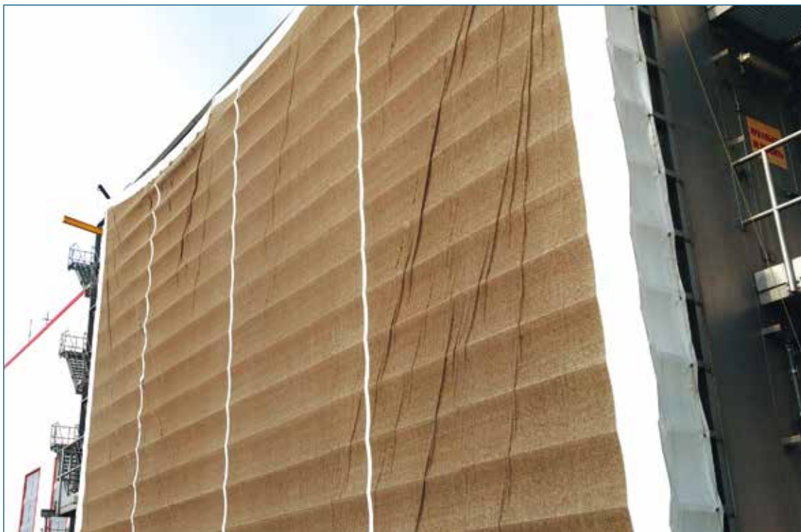
Рис. 14. Противомосkitная сетка из материала образца №3 на КБОУ ГТУ
