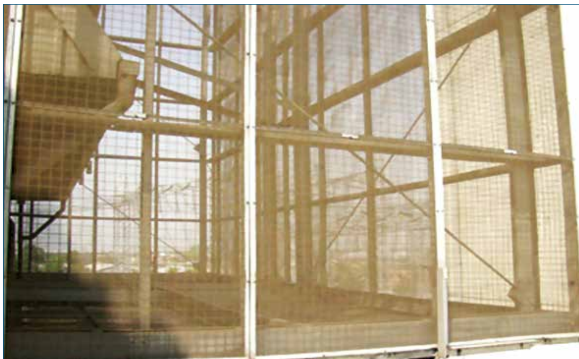
Рис. 2. Защитная сетка перед КВОУ ГТУ в Бангладеш
