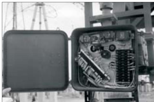
**Рис. 7. Общая компоновка оборудования в электрическом шкафу разъединителя 500 кВ с двигателем приводом на подстанции 500/220/110 кВ Сомкинская Сургутских электрических сетей**
