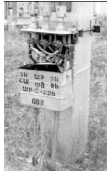
Рис. 4. Электрический шкаф разъединителя 220 кВ с деформированной нижней полкой
