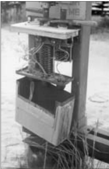
Рис. 5. Конструкция электрического шкафа разъединителя 110 кВ на подстанции 110/35/6 кВ Вега Сургутских электрических сетей с выдвижной шторкой для блок-замков
