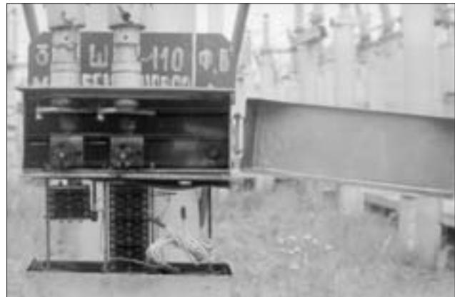
Рис. 6. Общий вид электрического шкафа разъединителя 110 кВ на подстанции 220/110 кВ Полоцкая Сургутских электрических сетей, состоящего из трех секций, секция блок-замков открыта в сторону, корпус шкафа, закрывающий нижние секции, опущен вниз
