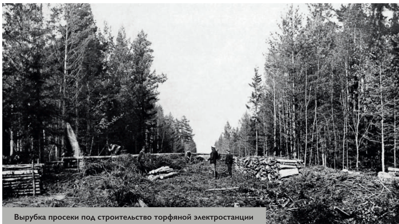
Строительство электростанции в Шатуре
