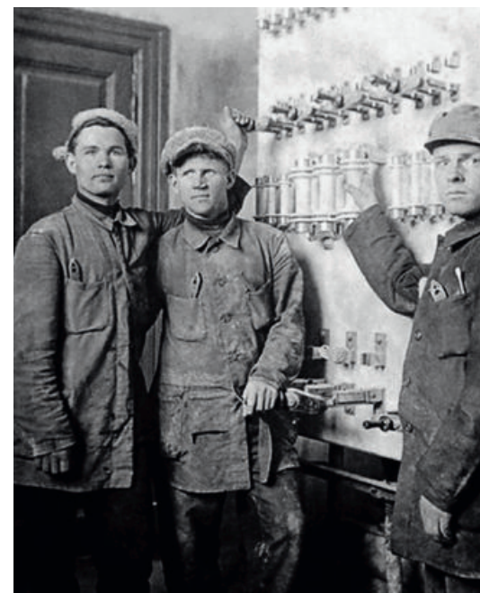
Монтеры электростанции, 1928 год
