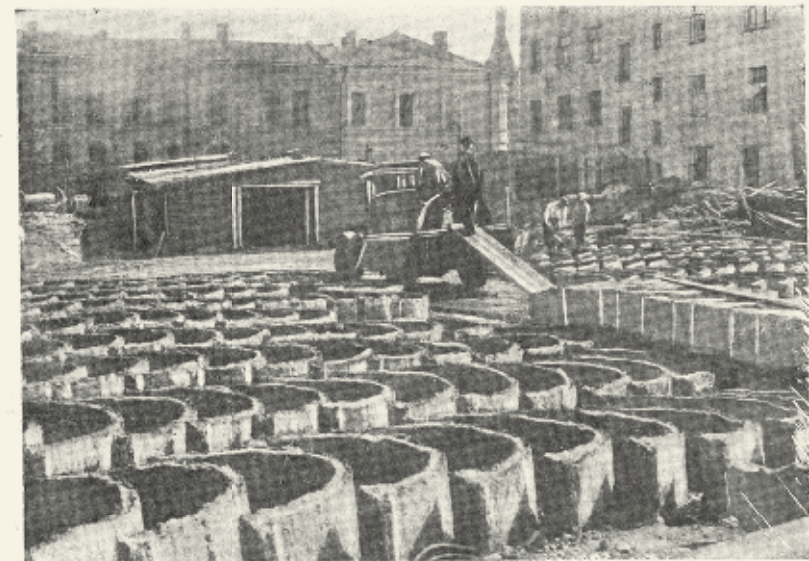
Железобетонные коллекторы для перекрытия теплопроводов в пехе перед отправкой на трассу (1934 г.)
