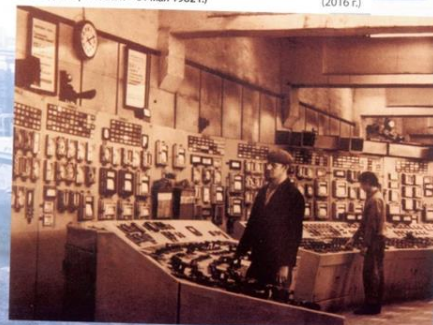
Машинисты Матил С.М., Якушев В.Г. на пульте управления котлами №7-8.
