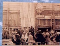
Собрание строителей 2 участка (1932 г.)
