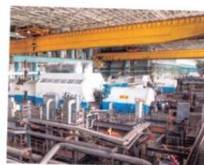
Машинный зал котло-турбинного цеха (2016 г.)
