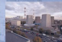
Вид на градирни ТЭЦ-11 в настоящее время
