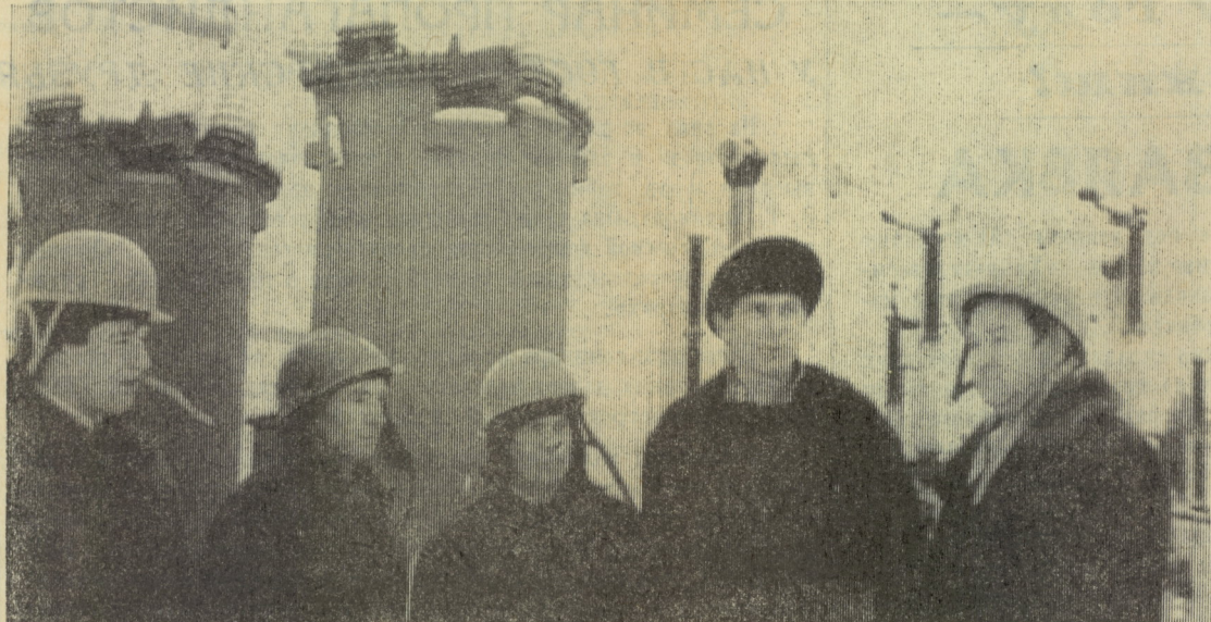
Ко Дню энергетика труженики Ногинских электрических сетей ввели в эксплуатацию первую очередь новой районной подстанции с трансформатором, мощность которого равна мощности всех подстанций, действующих в районе в 1940 году.
